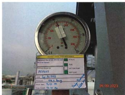
ภาพถ่ายกับตู้ควบคุมหม้อไอน้ำ และเตจวัดแรงดัน (HP DRUM)
