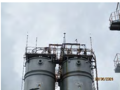
ภาพที่ 2.2-52 ติดตั้งสายล่อฟ้าตามมาตรฐานฯ
