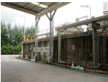
บ่อพักน้ำฉุกเฉินขนาด 1,500 ลูกบาศก์เมตร
