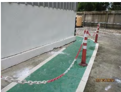
ภาพที่ 2.2-42 สิ่งกีดขวาง (Barrier) ป้องกันการเกิดอุบัติเหตุจากยานพาหนะ
