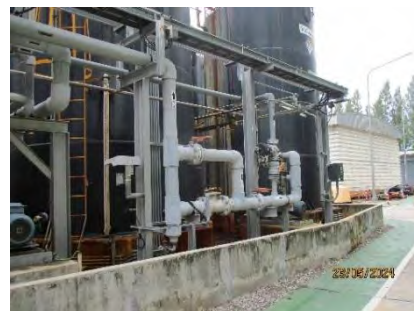
ภาพที่ 2.2-38 คันกั้น (Dike) คอนกรีตล้อมรอบ ถังเก็บสารเคมีบริเวณถัง
