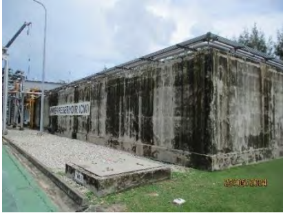
ภาพที่ 2.2-33 บ่อน้ำสำรองขนาด 1,200 ลูกบาศก์เมตร
