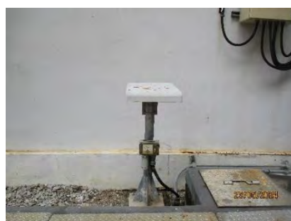
ภาพที่ 2.2-4 เครื่องตรวจวัดคลอรีน (Chlorine Gas Detector)
