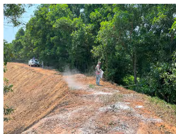
รูปที่ 2-2.1 (4) การปรับปรุงคุณภาพดินของโครงการ
