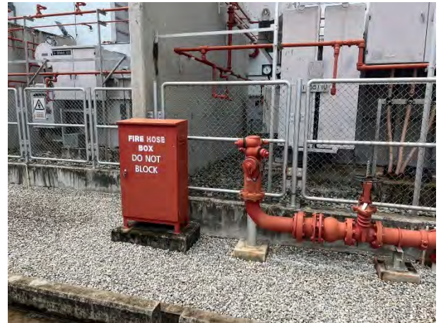
รูปที่ 2-14.10 อุปกรณ์ดับเพลิงภายนอกอาคาร
