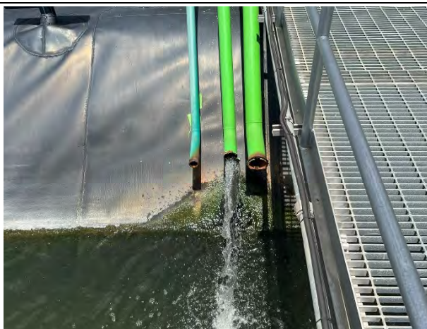
รูปที่ 2-5.3 น้ำทิ้งที่ผ่านการบำบัดไหลไปยังบ่อพักน้ำทิ้ง 1
