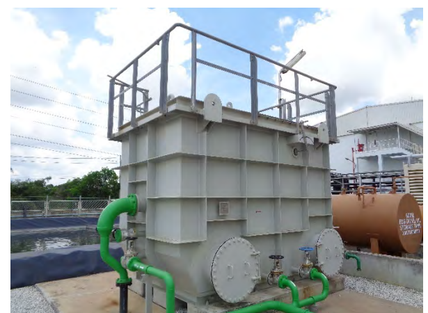
รูปที่ 2-5.4 ระบบ Oil Separator
