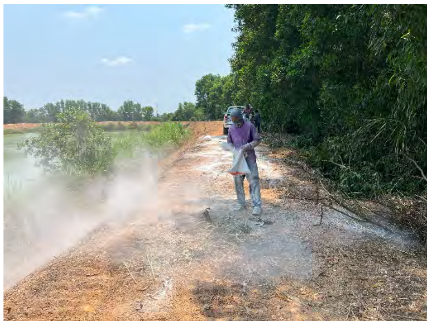
รูปที่ 2-2.1 (1) การปรับปรุงคุณภาพดินของโครงการ
