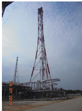
ภาพที่ 2.2-3 หอเผาที่จ้งระดับเหนือพื้นดิน (Elevated Flare)
