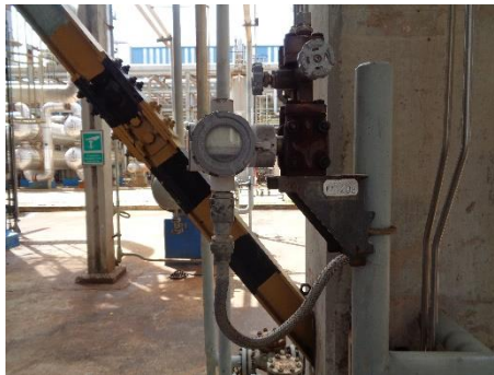
ภาพที่ 2.2-35 อุปกรณ์วัดอัตราการไหล ความดันและอุณหภูมิ บริเวณพื้นที่กระบวนการผลิต
