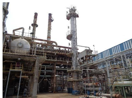
ภาพที่ 2.2-10 ระบบ Sour Water Stripping Unit (SWS1)
