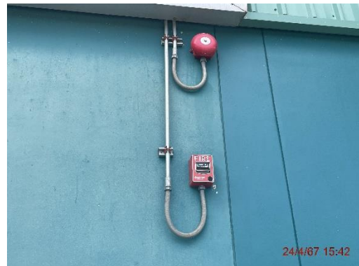
รูปที่ 43 อุปกรณ์ป้องกันและระงับอัคคีภัยในพื้นที่โครงการ
