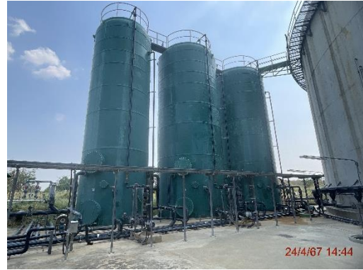
รูปที่ 2 ระบบรวบรวมและกำจัดก๊าซ H 2 S
