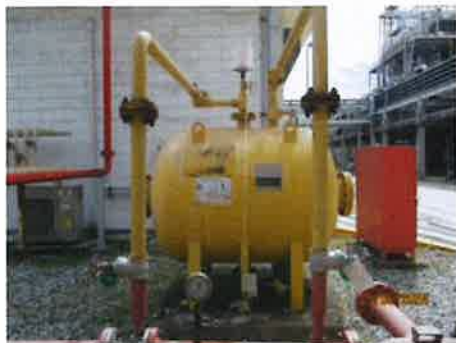
รูปที่ 3-45 Bladder Foam Tank
