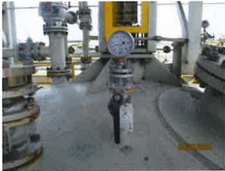
รูปที่ 3-54 Pressure Indicator บริเวณถังกักเก็บ
