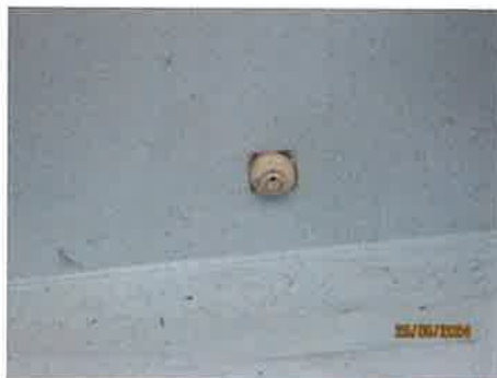
รูปที่ 3-41 Heat Detector บริเวณอาคารต่างๆ
