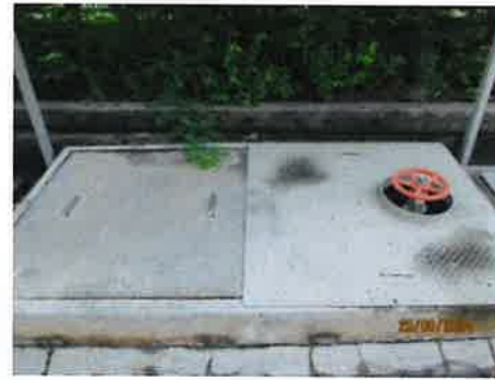
รูปที่ 3-30 บ่อ (Sump) รวบรวมสารเคมีที่อาจหกรั่วไหล
