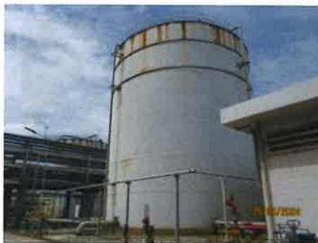
รูปที่ 3-43 ถังเก็บสำรองน้ำดับเพลิง
