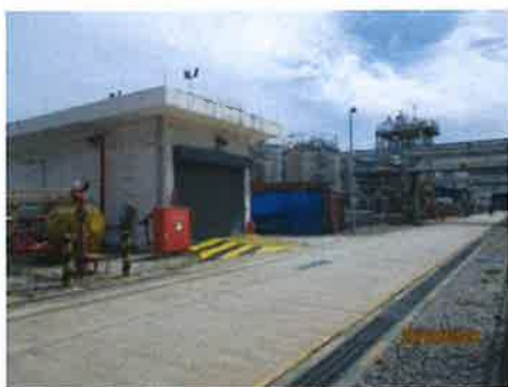
รูปที่ 3-47 การติดตั้ง Hydrant ทุกระยะ 50 เมตร
