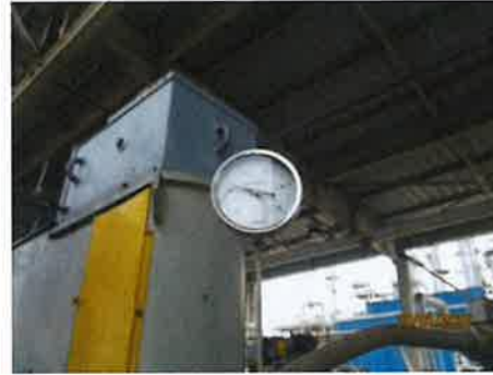
รูปที่ 3-55 Temperature Indicator บริเวณถังกักเก็บ
