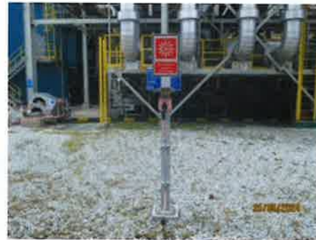
รูปที่ 3-42 Fire Alarm Manual System
