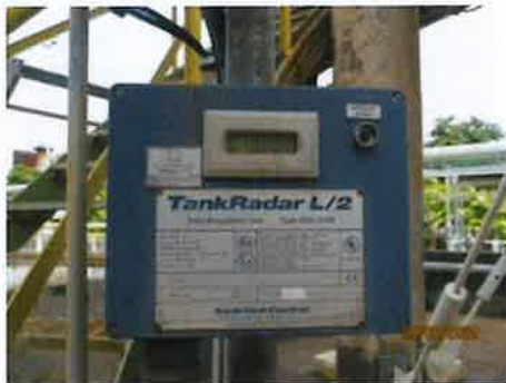
รูปที่ 3-56 Level Indicator บริเวณถังกักเก็บ
