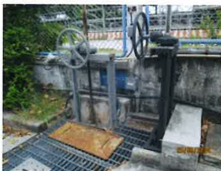
รูปที่ 3-64 Sluice Gate
