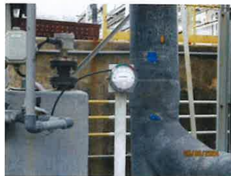
รูปที่ 3-18 Pressure Gauge ป่อ Surge II
