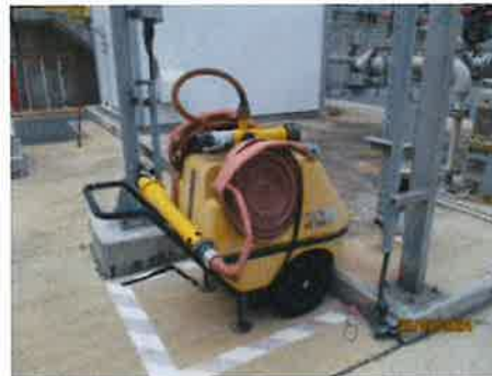
รูปที่ 3-46 Mobile Foam Tank
