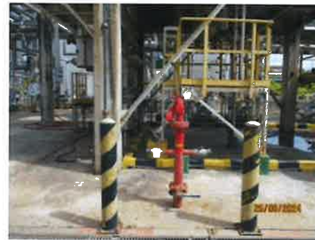
รูปที่ 3-53 Water Hydrant บริเวณกระบวนการผลิต
