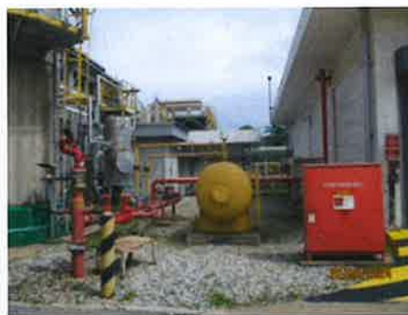
รูปที่ 3-46 Mobile Foam Tank
