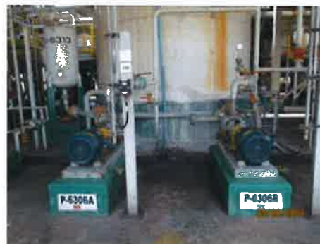
รูปที่ 3-9 Double Mechanical Seal Pump
