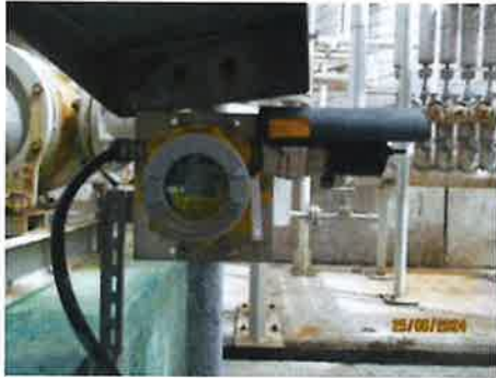
รูปที่ 3-39 Gas Detector บริเวณกระบวนการผลิต
