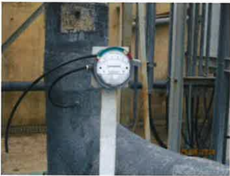
รูปที่ 3-17 Pressure Gauge ป่อ Surge I
