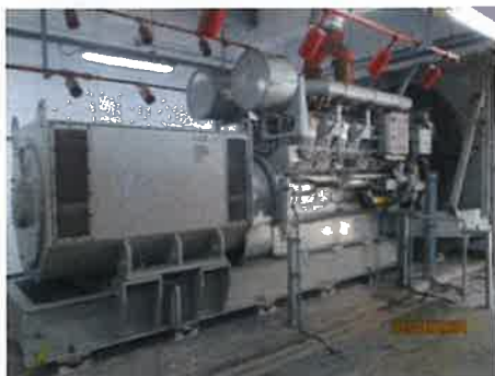
รูปที่ 3-21 เครื่องกำเนิดไฟฟ้าสำรอง (Emergency Generator)
