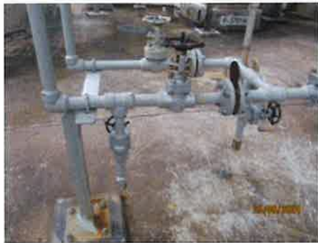
รูปที่ 3-10 Line Drain ที่มีฝาปิด
