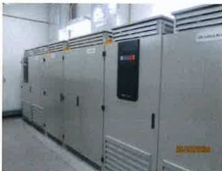
รูปที่ 3-50 ระบบไฟฟ้าสำรองแบบยูพีเอส (UPS)
