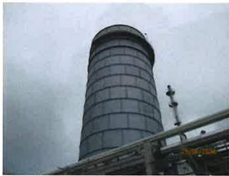
รูปที่ 3-5 หอเผาที่ระดับเหนือพื้นดินแบบมิดชิด (Enclosed Ground Flare)
