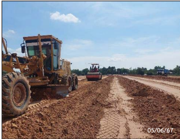
รูปที่ 2-34 กิจกรรม Embankment Fill
