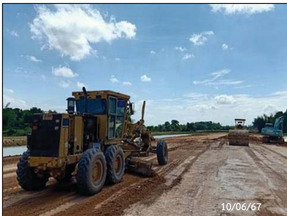
รูปที่ 2-76 กิจกรรม Embankment Fill กม.81+820-กม.82+300
