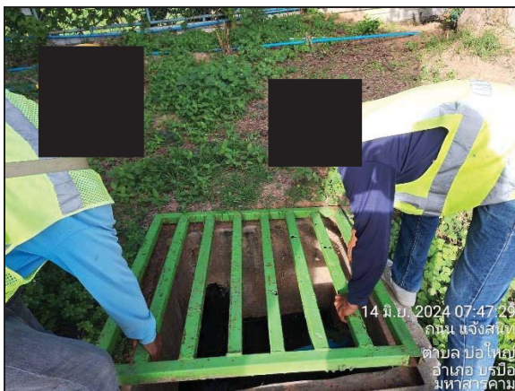
รูปที่ 2-19 การดูแลรักษาและขุดลอกตะกอนในรางระบายน้ำ
