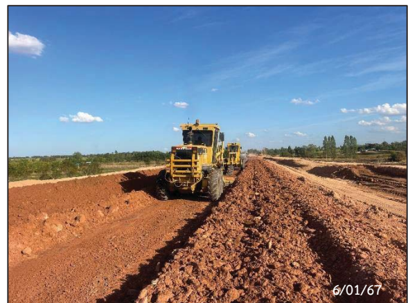
รูปที่ 2-83 กิจกรรม Clearing And Grubbing และ กิจกรรม Embankment Fill กม.8+400-9+700 ผลการปฏิบัติตามมาตรการป้องกันและแก้ไขผลกระทบสิ่งแวดล้อมฯ สัญญาที่ 1 ช่วงบ้านไผ่-หนองพอก
