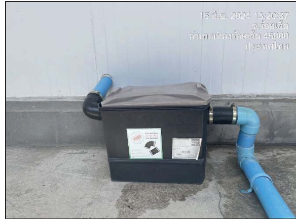
รูปที่ 2-8 ระบบบำบัดน้ำเสียสำเร็จรูปและถังดักไขมัน บริเวณพื้นที่สำนักงานก่อสร้าง
