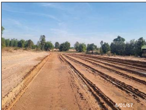
รูปที่ 2-83 กิจกรรม Clearing And Grubbing และ กิจกรรม Embankment Fill กม.8+400-9+700 ผลการปฏิบัติตามมาตรการป้องกันและแก้ไขผลกระทบสิ่งแวดล้อมฯ สัญญาที่ 1 ช่วงบ้านไผ่-หนองพอก
