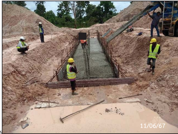
รูปที่ 2-74 กิจกรรมก่อสร้าง Box Culvert
