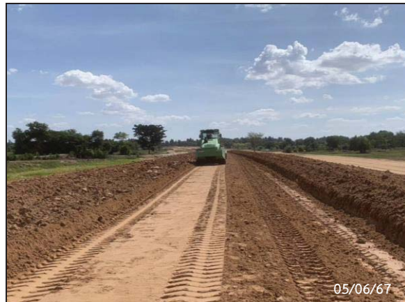
รูปที่ 2-36 การปรับถมหน้าดินปรับเกลี่ยหน้าดิน และบดอัดหน้าดิน
