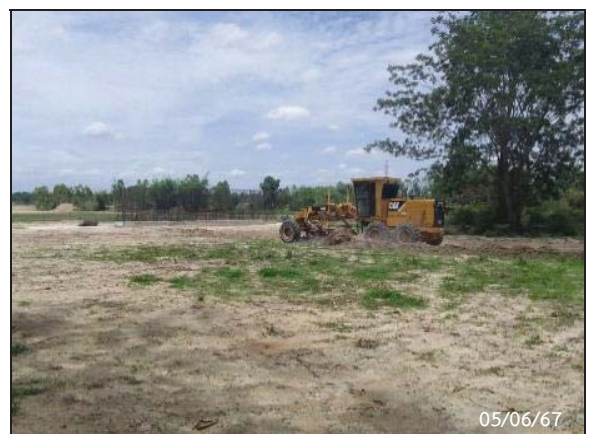
รูปที่ 2-33 กิจกรรม Clearing และ Grubbing
