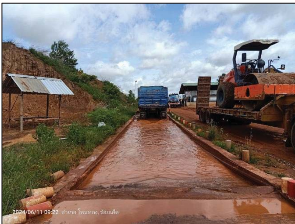
รูปที่ 2-5 จัดเตรียมพื้นที่สำหรับทำความสะอาดล้อรถบรรทุก บริเวณสำนักงาน พื้นที่ก่อสร้างโซนที่ 4
