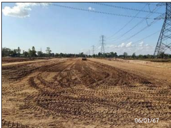
รูปที่ 2-86 กิจกรรม Clearing And Grubbing และ กิจกรรม Embankment Fill กม.93+000-95+000
