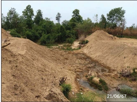
รูปที่ 2-80 การขุดดินให้เป็นแนวลาดเอียงเพื่อป้องกัน การพังทลาย
