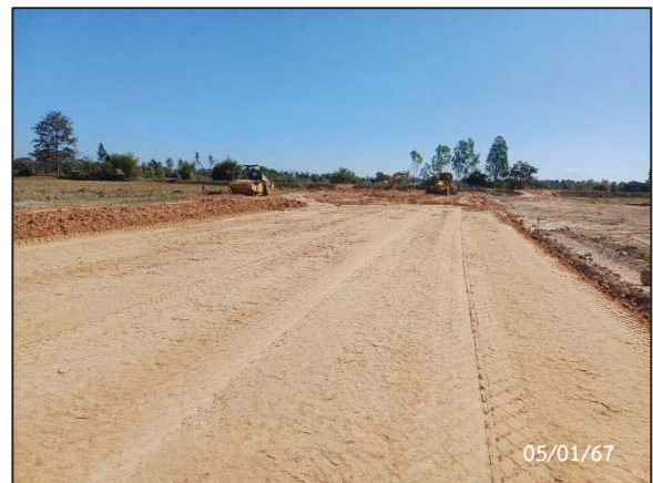
รูปที่ 2-86 กิจกรรม Clearing And Grubbing และ กิจกรรม Embankment Fill กม.93+000-95+000
