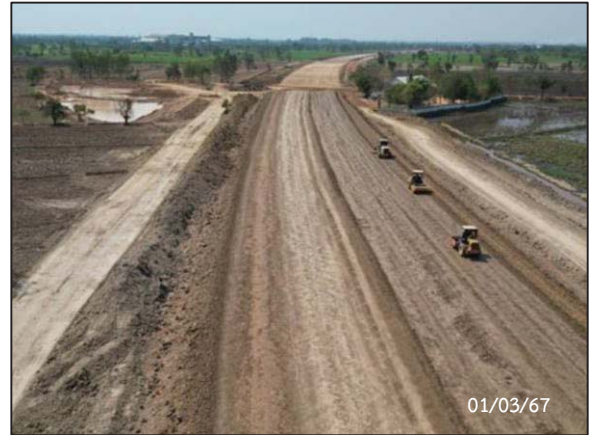
รูปที่ 2-85 กิจกรรม Embankment Fill กม.78+860-กม.79+320
