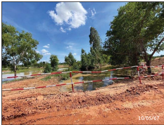
รูปที่ 2-44 การกำหนดขอบเขตพื้นที่ก่อสร้าง บริเวณตลิ่ง
