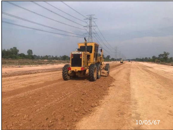
รูปที่ 2-84 กิจกรรม Embankment Fill กม.70+280-กม.70+600
