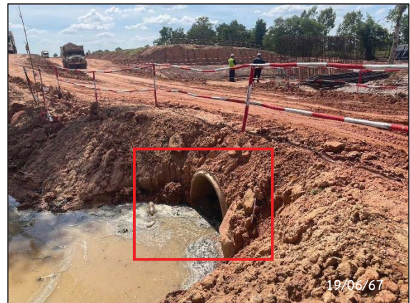
รูปที่ 2-70 การติดตั้งท่อลอดระบายน้ำคอนกรีตกลม
