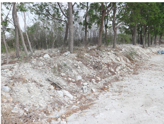
รูปที่ 3-5 เปลือกดินและเศษดินนำกลับมาถมปรับพื้นที่บริเวณบ่อขุดเหมือง
