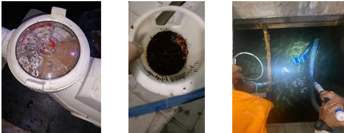
รูปที่ 2-29 การทำความสะอาดถังเก็บน้ำดี (ระบบน้ำประปา)
