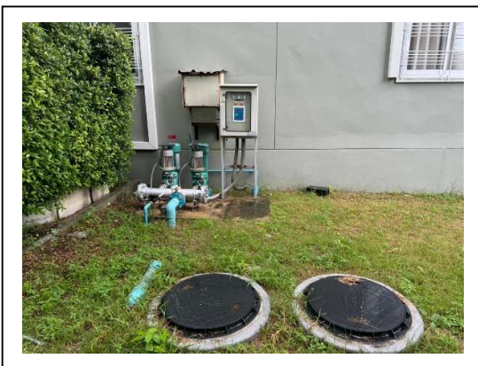
รูปที่ 2.1-12 ติดตั้งระบบบำบัดน้ำเสียให้เป็นไปตามที่ออกแบบ (อาคาร B-C)
