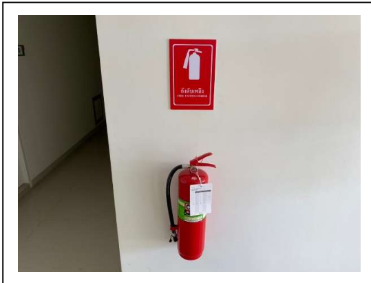
รูปที่ 2.1-31 ติดตั้งเครื่องดับเพลิงแบบมือถือ เป็นเครื่องดับเพลิงเคมีความจุ 15 ปอนด์ (จุดที่ 2)
