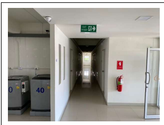
รูปที่ 2.1-29 ติดตั้งป้ายบอกตำแหน่งทางหนีไฟเป็นป้ายพลาสติกเรืองแสง
