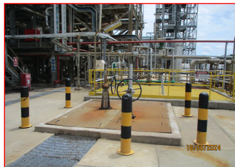
(24) บ่อรวบรวมน้ำเสียจากพื้นที่กระบวนการผลิต
