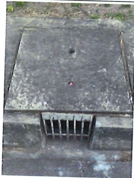
ภาพที่ 15 ตะแกรงดักขยะ
