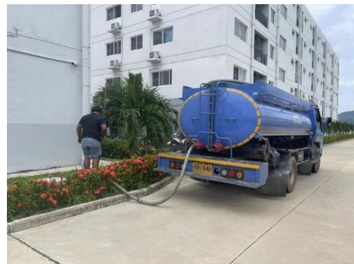
รูปที่ 7 การสูบน้ำจากถังบำบัดน้ำเสีย
