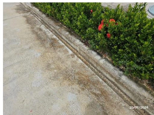
รูปที่ 8 รางระบายน้ำของโครงการ
