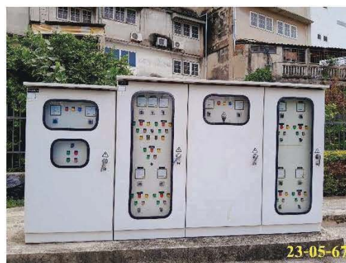
พื้นที่ระบบบำบัดน้ำเสีย พร้อมตู้ควบคุม
