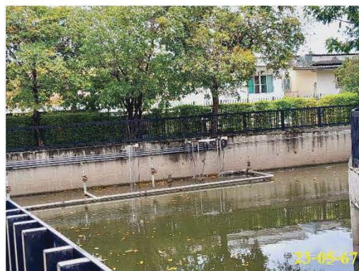
บ่อพักน้ำสุดท้ายก่อนระบายออกนอกโครงการพร้อมเครื่องเติมอากาศ
