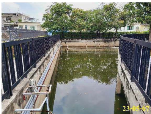
บ่อพักน้ำสุดท้ายก่อนระบายออกนอกโครงการพร้อมเครื่องเติมอากาศ
