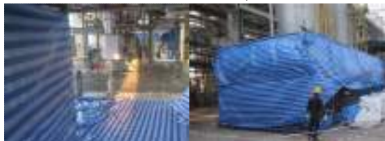
ภาพตัวอย่างการปิดกั้นพื้นที่ ป้องกันการฟุ้งกระจายฉนวน
