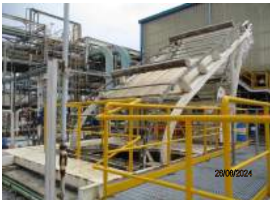
รูปที่ 2-7 บ่อดักโพลิเมอร์และเครื่องตกตะกอน
