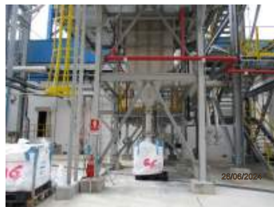
รูปที่ 2-32 ระบบรวบรวมฝุ่นจากบริเวณที่มีการฟุ้งกระจาย ของสารเติมแต่ง
