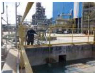
บ่อพักน้ำทิ้ง (Retention Basin) ของหน่วยผลิตที่ 3
