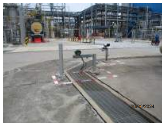
รูปที่ 2-25 ระบบตรวจวัดการรั่วไหลของแก๊ส (Gas Detector)
