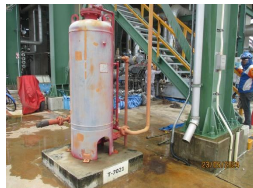
ระบบสเปรย์โฟม (Foam Spray System)
