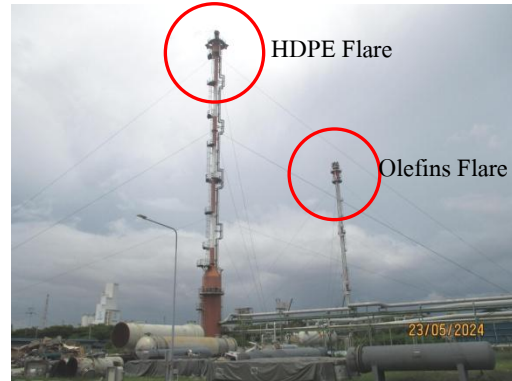
รูปที่ 3-3 หอเผาชนิด Elevated Flare (EF) (Olefins Flare (โรงที่ 1/1), HDPE Flare)
