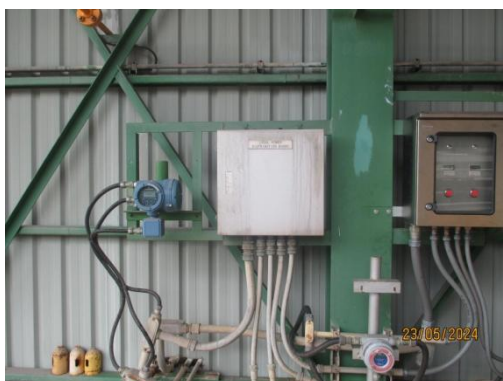
รูปที่ 3-65 Chlorine Gas Detector
