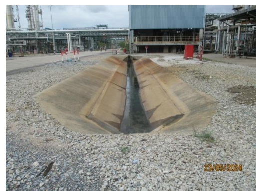
รูปที่ 3-16 รางระบายน้ำฝนทั่วไป แยกจากจุดรับน้ำฝนทั่วป็นเป็น
