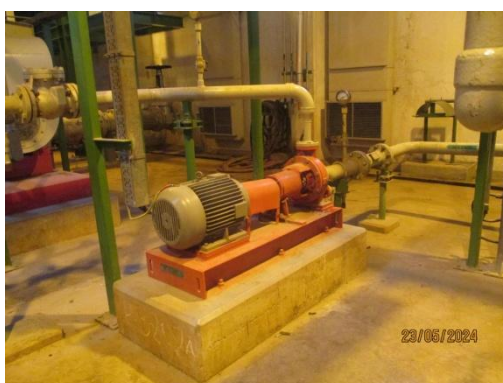
เครื่องสูบน้ำเพิ่ม/รักษาแรงดัน (Jockey Pump)
