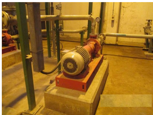
เครื่องสูบน้ำดับเพลิงเดินด้วยไฟฟ้า
