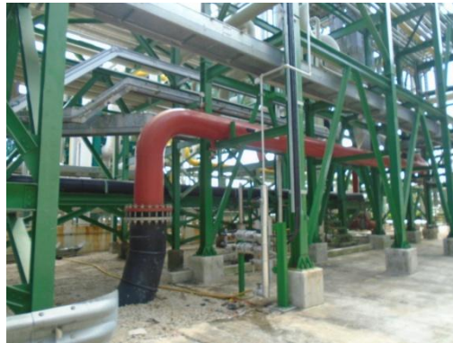
รูปที่ 3-72 ระบบเชื่อมต่อน้ำดับเพลิงระหว่าง
