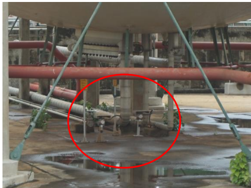
รูปที่ 3-55 Hydrocarbon Gas Detector
