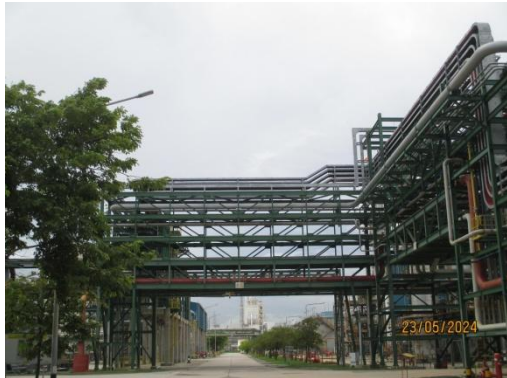
รูปที่ 3-59 Pipe Rack รองรับท่อรับวัตถุดิบ
