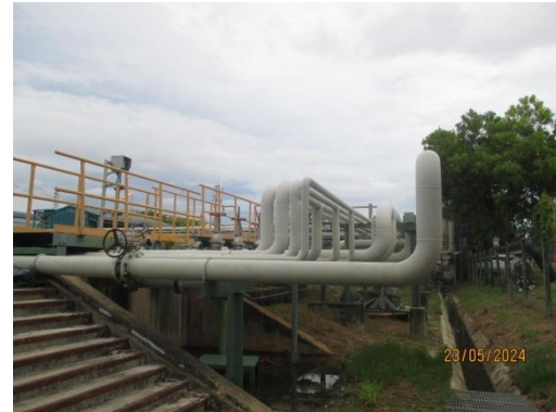
รูปที่ 3-13 จุดระบายน้ำจากระบบหล่อเย็นและ น้ำระบายทิ้งจาก Back Wash Side Steam Filter
