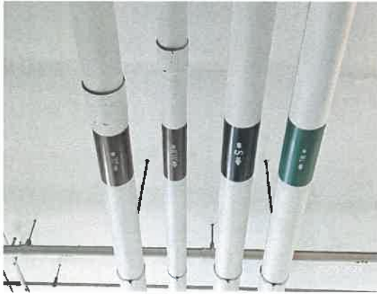
รูปที่ 36 ท่อรวบรวมน้ำเสียจากห้องพักมูลฝอย
