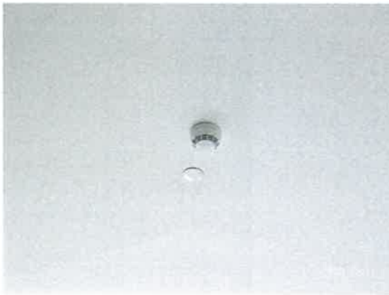
รูปที่ 59 เครื่องตรวจจับควัน (Smoke Detector)
