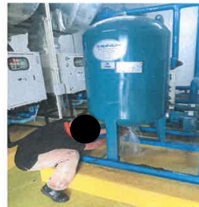
รูปที่ 20 ช่างซ่อมบำรุงตรวจสอบรอยรั่ว
