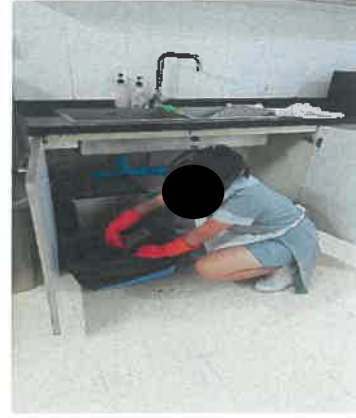
รูปที่ 14 พนักงานดักไขมันจากถังดักไขมัน
