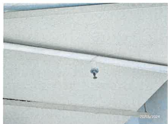
รูปที่ 56 ระบบหัวกระจายน้ำดับเพลิงอัตโนมัติ (Sprinkler System)
