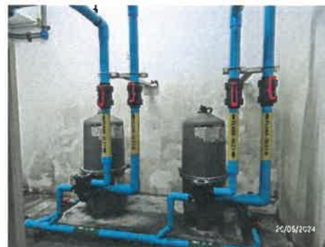
รูปที่ 3-49 ระบบกรองน้ำสระว่ายน้ำ
