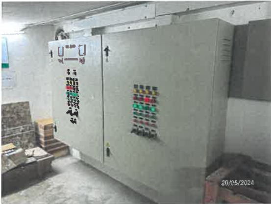
รูปที่ 15 ระบบมิเตอร์ไฟฟ้าสำหรับระบบบำบัดน้ำเสีย
