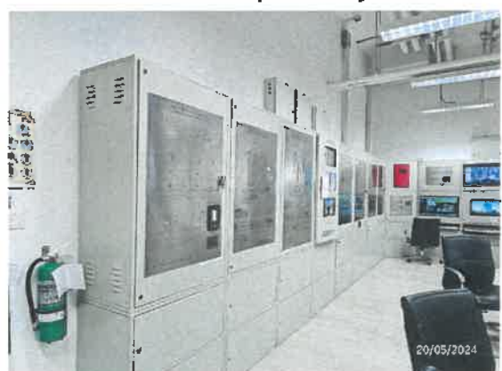
รูปที่ 58 แผงควบคุม เพื่อทำหน้าที่เป็นจุดศูนย์รวมการรับ-ส่งสัญญาณตรวจรับ
