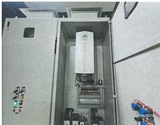
รูปที่ 48 อุปกรณ์ปรับความเร็วรอบมอเตอร์ VSD
