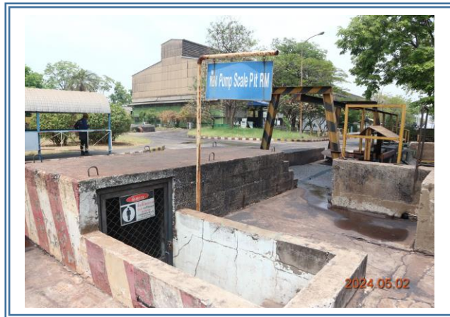
รูปที่ 3.7 บ่อดักตะกอน (Scale) ภายในโครงการ
