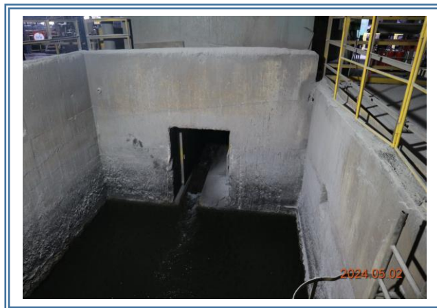
รูปที่ 3.8 บ่อดักตะกอน (Scale) ภายในโรงเหล็กแท่ง
