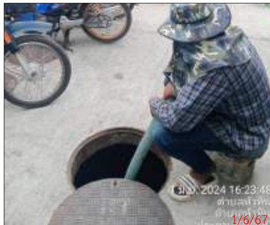
การสูบลบตะกอนจากบ่อเก็บตะกอนภายในโครงการ
