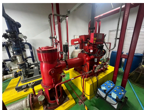
ระบบน้ำดับเพลิงอัตโนมัติในอาคาร
