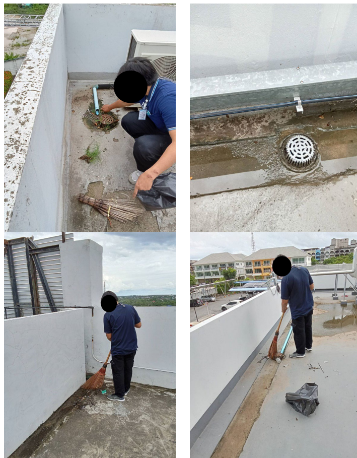
รูปที่ 2-21 ตะแกรงดักตะกอน และการทำความสะอาดรางระบายน้ำภายในอาคาร
