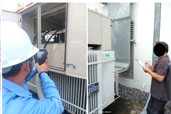
รูปที่ 2-36 การตรวจสอบหม้อแปลง ขนาด 2,000 KVA ของโครงการ
