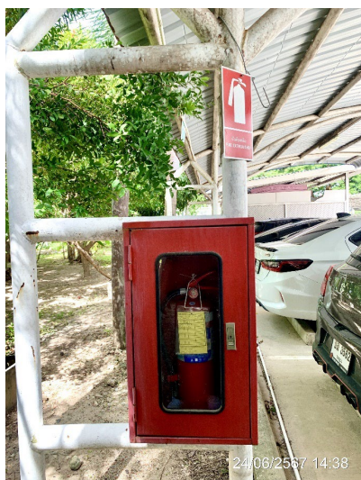
ถังดับเพลิงพร้อมวิธีการใช้งานติดตั้งภายนอกอาคาร
