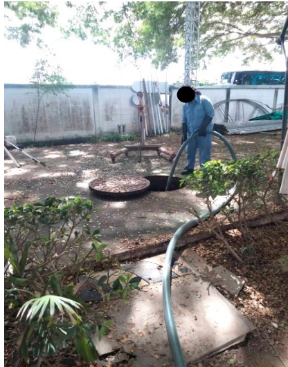
รูปที่ 2-13 เทศบาลตำบลเชิงเนินเข้ามาสูบตะกอนระบบบำบัดน้ำเสีย
