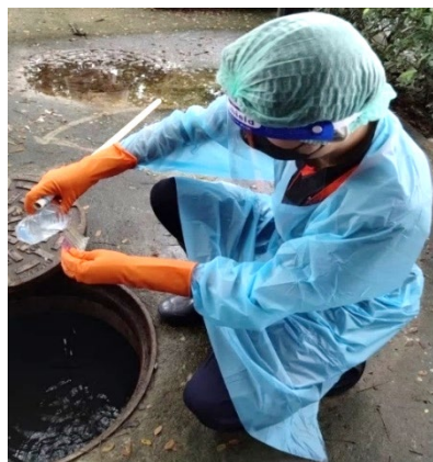
รูปที่ 3.5-3 การเก็บตัวอย่างน้ำเพื่อตรวจสอบประสิทธิภาพระบบบำบัดน้ำเสีย
