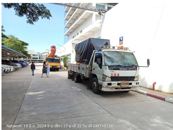
รูปที่ 2-4 ปิดคลุมรถมิดชิดขณะขนย้ายวัสดุก่อสร้าง
