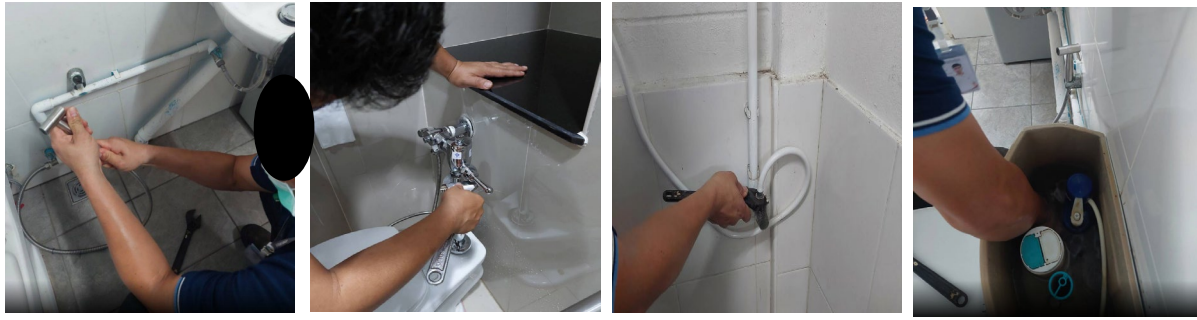
รูปที่ 2-40 ตรวจสอบและซ่อมแซมระบบจ่ายน้ำประปาภายในโครงการ
