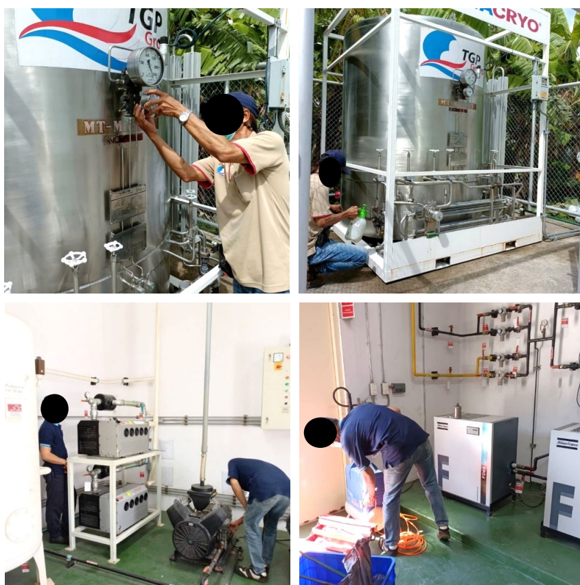
รูปที่ 2-48 การตรวจสอบดูแลระบบออกซิเจนเหลว 1 ครั้ง/ปี และระบบแก๊สทางการแพทย์
