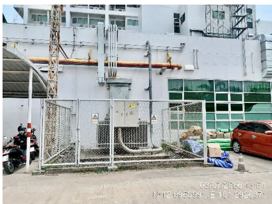
รูปที่ 2-36 การตรวจสอบหม้อแปลง ขนาด 2,000 KVA ของโครงการ
