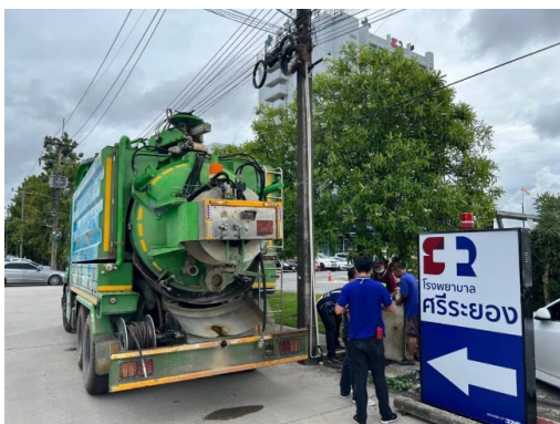
รูปที่ 2-22 เจ้าหน้าที่เทศบาลตำบลเชิงเนินขุดลอกท่อระบายน้ำ
