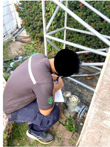
รูปที่ 2-43 การตรวจเช็คมิเตอร์น้ำและจดบันทึกปริมาณการใช้น้ำเป็นประจำ
