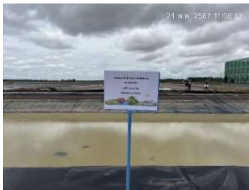
รูปที่ 2-45 บ่ออุกฉิน (ระบบบำบัดน้ำเสียความสกปรกต่ำ)
