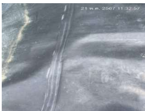
รูปที่ 2-47 แผ่นพลาสติก HDPE กันซึม ของระบบบำบัดน้ำเสีย
