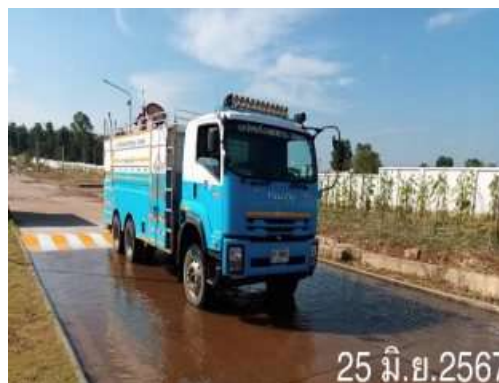
รูปที่ 2-20 พื้นที่สำหรับล้างล้อรถบรรทุก ก่อนออกนอกพื้นที่โครงการ
