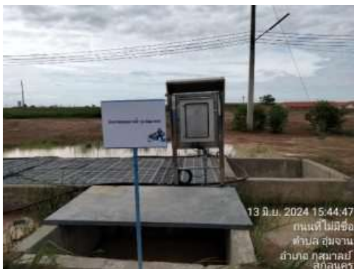
รูปที่ 2-39 เครื่องตรวจสอบคุณภาพน้ำเสียแบบอัตโนมัติ (ระบบบำบัดน้ำเสียความสกปรกสูง)
