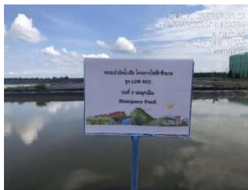
รูปที่ 2-42 บ่อปรับสภาพน้ำทิ้ง (ระบบบำบัดน้ำเสียความสกปรกต่ำ)
