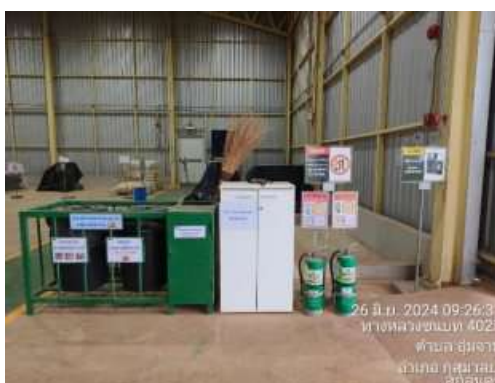
รูปที่ 2-76 อุปกรณ์ป้องกันอัคคีภัยบริเวณอาคารเก็บสารเคมี
