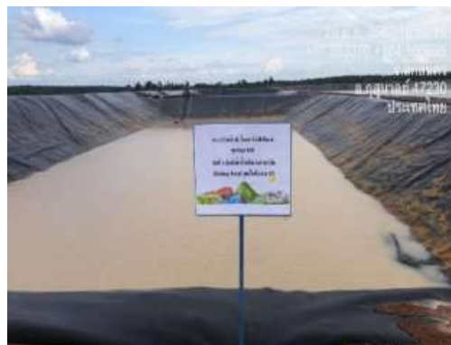
รูปที่ 2-40 บ่อพักน้ำทิ้ง (ระบบบำบัดน้ำเสียความสกปรกสูง)
