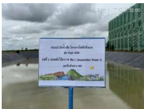
รูปที่ 2-35 บ่อหมักไร้อากาศ No.1 (ระบบบำบัดน้ำเสียความสูงปรกสูง)
