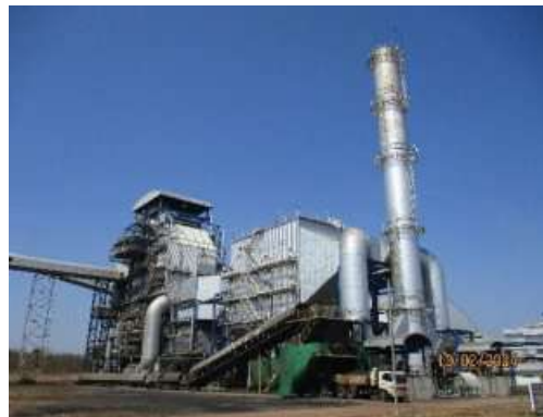
รูปที่ 2-3 หม้อไอน้ำ No.1 (ขนาด 250 ตัน/ชั่วโมง)
