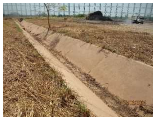
รูปที่ 2-13 รางระบายน้ำชะลานกองเก็บกากอ้อย
