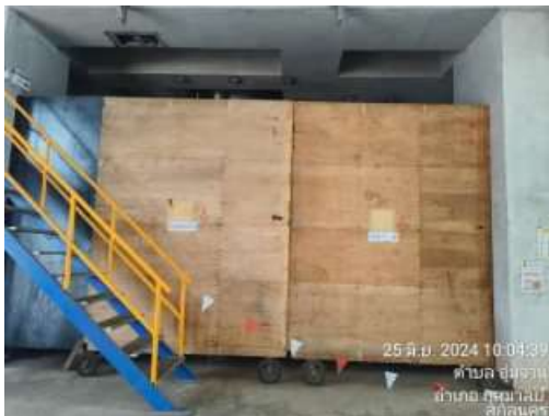
รูปที่ 2-27 วัสดุครอบปิดแหล่งกำเนิดเสียงดัง
