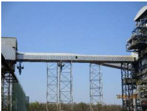
รูปที่ 2-15 ระบบสายพานลำเลียงกากอ้อยไปยัง โรงไฟฟ้าชีวมวล
