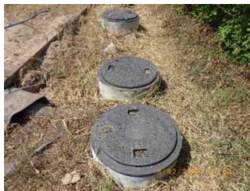
รูปที่ 2-32 ระบบบำบัดน้ำเสียและ ถังเกรอะ-กรองไร้อากาศ
