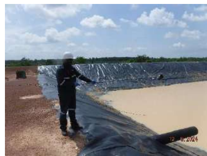
บ่อบำบัดน้ำเสียแบบไร้อากาศบ่อแรก (W2)
