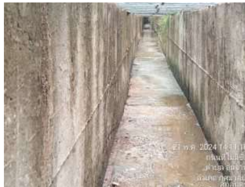
รูปที่ 2-28 รางระบายน้ำรวบรวมน้ำฝนลงสู่บ่อเก็บน้ำดิบ
