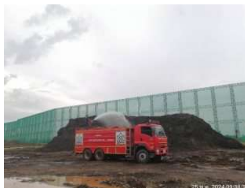
รูปที่ 2-18 การฉีดพรมน้ำรอบลานกองเก็บแฉะ
