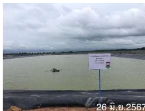
รูปที่ 2-38 บ่อเติมอากาศ (ระบบบำบัดน้ำเสียความสูงปรกสูง)
