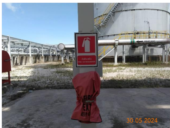
รูปที่ 2-23 เครื่องมือดับเพลิงขั้นต้นชนิดผงเคมีแห้ง
