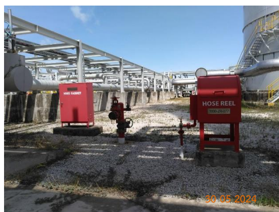
รูปที่ 2-24 หัวจ่ายน้ำดับเพลิงและตู้ดับเพลิงพร้อมสายน้ำ
