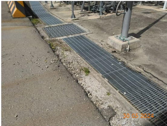
รูปที่ 2-13 รางระบายน้ำฝนภายในพื้นที่โครงการ
