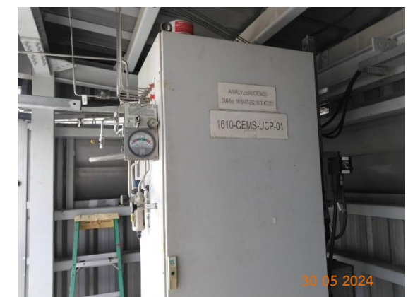
รูปที่ 2-6 เครื่องมือควบคุมระบบตรวจสอบมลพิษทางอากาศ แบบต่อเนื่อง (CEMs)
