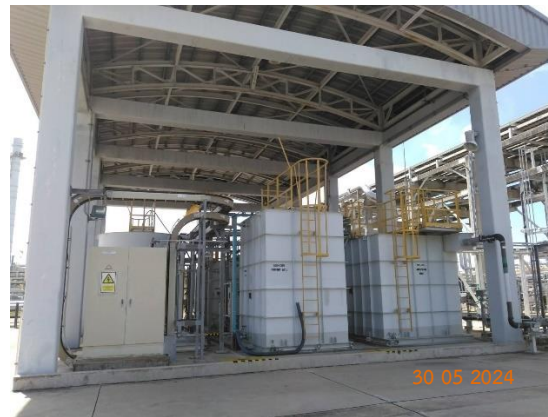
รูปที่ 2-11 ระบบบำบัดน้ำเสียแบบชีวภาพของสถานีรับ-จ่ายก๊าซธรรมชาติเหลว
