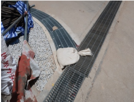
รูปที่ 7 รางระบายน้ำฝนในพื้นที่ก่อสร้าง
