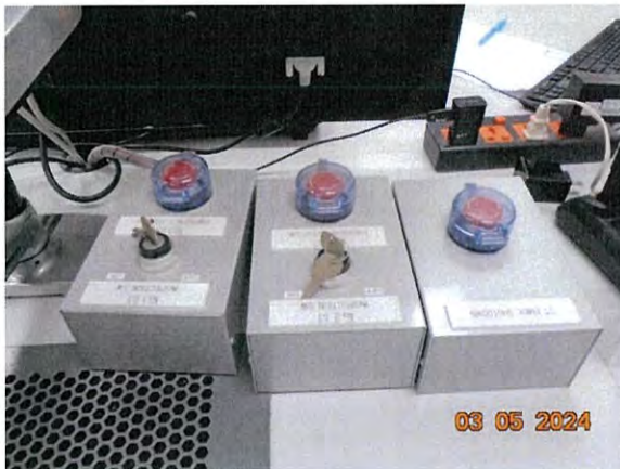
ภาพที่ 2.2-38 Emergency Switch
