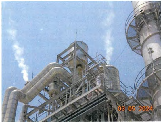
ภาพที่ 2.2-4 Silencer ทางออกไอเสียของเครื่องกังหันไอน้ำ (Steam blow)
