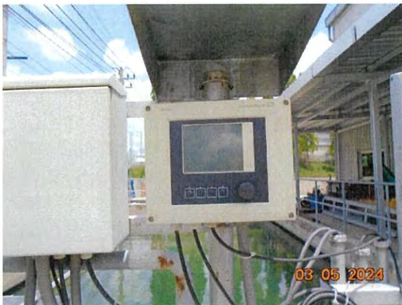
ภาพที่ 2.2-18 เครื่องวัดค่าความเป็นกรด-ด่าง และ เครื่องวัดค่าการนำไฟฟ้าแบบอัตโนมัติ
