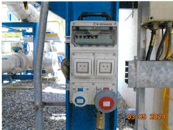
ภาพที่ 2.2-29 ระบบป้องกันไฟฟ้ารั่ว
