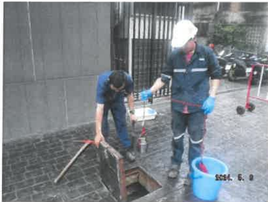
รูปที่ 3-1 การติดตามตรวจสอบคุณภาพน้ำทิ้ง บริเวณน้ำเสียเข้าสู่ระบบบำบัดน้ำเสีย
