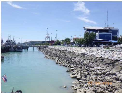
รูปที่ 2-3 แนว Revetment บริเวณท่าเรือแหลมฉบัง
