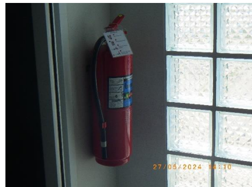
รูปที่ 2-34 สัญญาณแจ้งเหตุเพลิงไหม้ และถังดับเพลิงชนิดผงเคมีแห้ง
