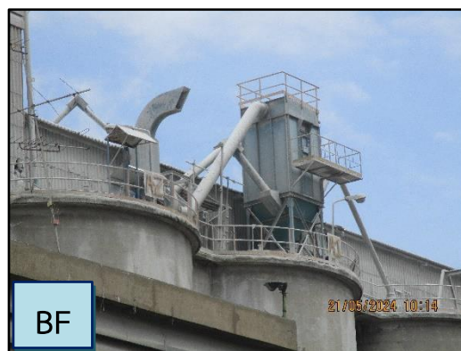
ภาพที่ 2.8 ระบบดักฝุ่นแบบ Bag Filter (BF)
