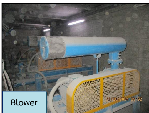
ภาพที่ 2.20 ห้องเก็บเสียงของ Blower และ Pfizer สำหรับป้องกันเสียงจากกระบวนการผลิต
