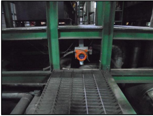
รูปที่ 17 การติดตั้ง Gas Detector ภายในห้องเครื่องยนต์
