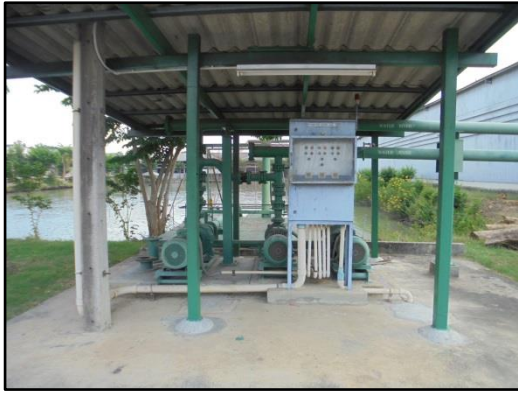
รูปที่ 5 การสูบน้ำจากคลองชลประทาน (คลองส่งน้ำสายสิบสองซ้าย)
