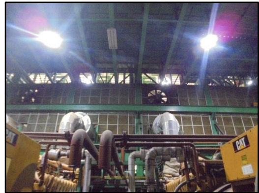
รูปที่ 20 การติดตั้งพัดลมระบายอากาศ
