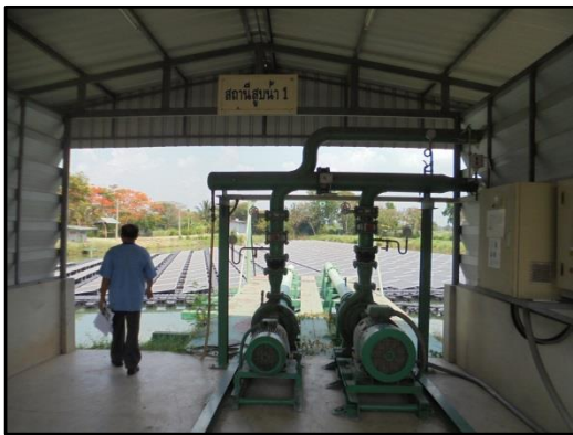
รูปที่ 6 การสูบน้ำจากบ่อบาดาล
