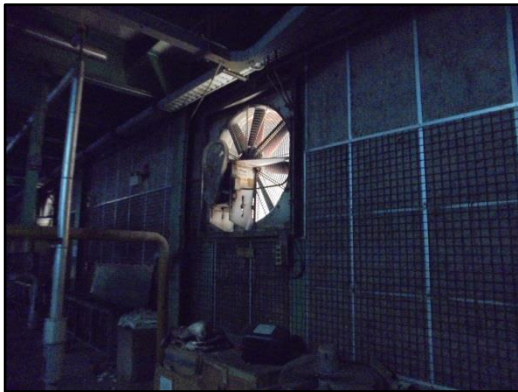
รูปที่ 20 การติดตั้งพัดลมระบายอากาศ
