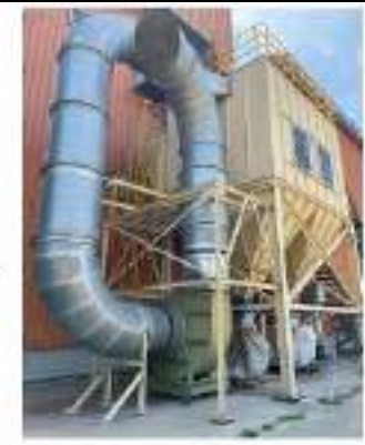
ฝุ่นถูกดูดเพื่อไปเก็บที่ Dust collector
