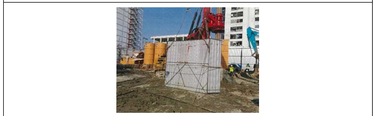
รูปที่ 16 กำแพงกันเสียงแบบเคลื่อนย้าย
