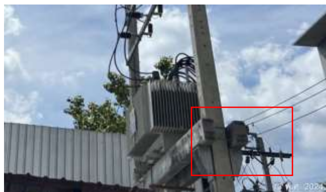
รูปที่ 37 หม้อแปลงและมิเตอร์ไฟฟ้าชั่วคราว
