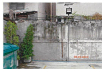
สภาพทั่วไป และรอยแตกชำรุดบริเวณแนวกำแพงด้านหลัง
