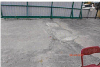
สภาพทั่วไป และรอยแตกร้าวบริเวณพื้นคอนกรีต
