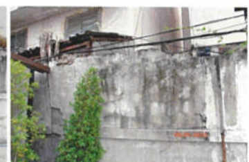
สภาพทั่วไป และรอยแตกชำรุดบริเวณแนวกำแพงด้านหลัง
