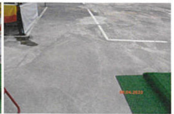
สภาพทั่วไป และรอยแตกร้าวบริเวณพื้นคอนกรีต
