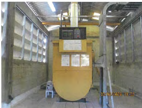
ภาพที่ 2-27 Diesel Generator
