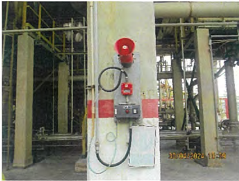
ภาพที่ 2-19 Fire Alarm และ Fire Alarm Panel
