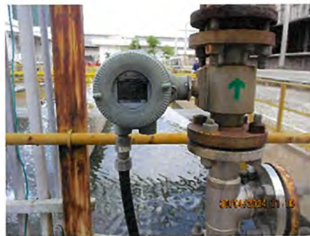
Flow Meter (ใช้ร่วมกันกับ PP1)
