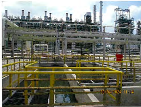
API Separator (ใช้ร่วมกันกับ PP1)
