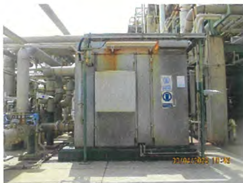
ภาพที่ 2-12 กล่องครอบลดเสียงดังจากเครื่องจักร และป้ายเตือนให้สวมใส่อุปกรณ์ป้องกันเสียงดัง
