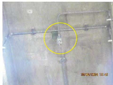
ภาพที่ 2-22 Heat Detector
