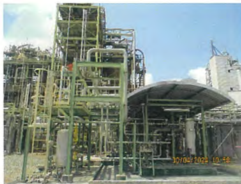
ภาพที่ 2-5 หน่วยนำกลับไอสารไฮโดรคาร์บอน (VOC Recovery Unit: VRU) ของโรงงานที่ 2
