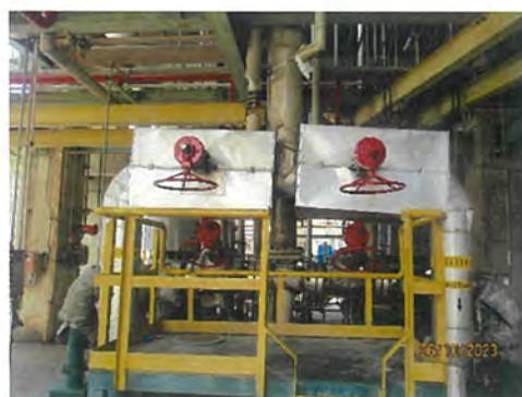
ภาพที่ 2-2 ระบบาล์วควบคุมระหว่างถังปฏิกรณ์ และการตรวจสอบระบบาล์วควบคุม และอุปกรณ์ควบคุม
