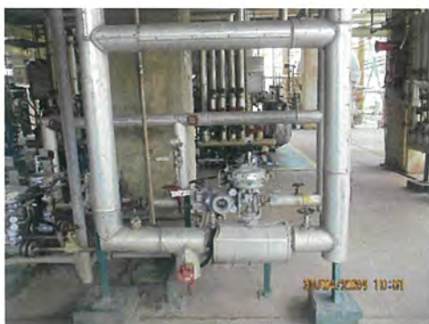
ภาพที่ 2-2 ระบบาล์วควบคุมระหว่างถังปฏิกรณ์ และการตรวจสอบระบบาล์วควบคุม และอุปกรณ์ควบคุม
