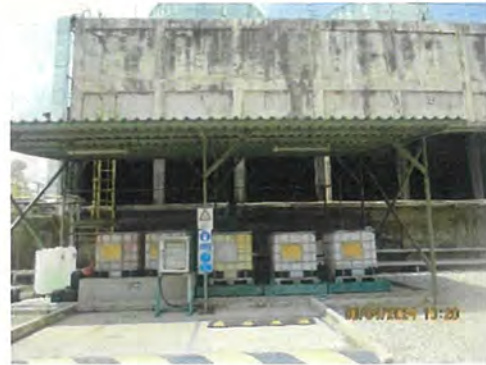
ภาพที่ 2-10 ถึง H_2SO_4 สำหรับปรับ pH ที่ API Separator (ใช้ร่วมกันกับ PP1)
