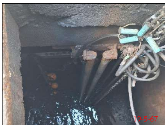
ติดตั้งเครื่องสูบน้ำแบบจุ่มภายในบ่อหนองน้ำ เพื่อสูบน้ำฝนคงค้างในบ่อขึ้นมาใช้ประโยชน์
