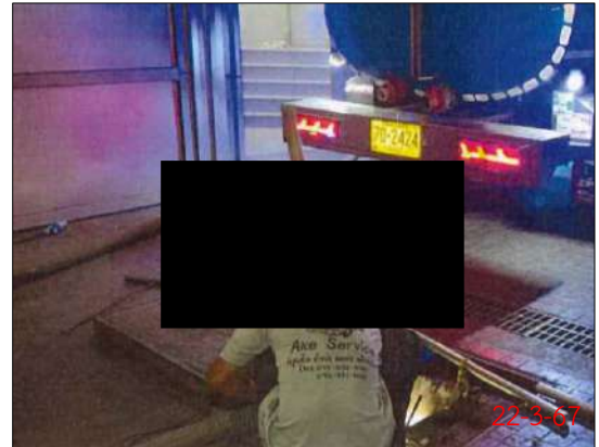
การสูบตะกอนจากบ่อเก็บตะกอน
