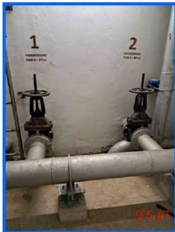
ถังเก็บน้ำใต้ดิน จำนวน 2 ถัง ขนาดความจุรวม 466 ลบ.ม.
