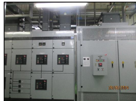
รูปที่ 2-50 ตู้ควบคุมระบบไฟฟ้าหลักของโครงการ (ตู้ MDB)
