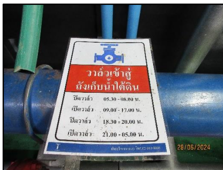
รูปที่ 2-31 ป้ายกำหนดเวลาปิด - เปิดวาล์วน้ำ เข้าสู่ถังเก็บน้ำใต้ดินของโครงการ
