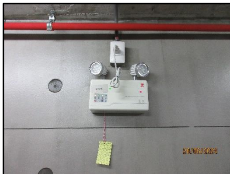
รูปที่ 2-61 ไฟฟ้าส่องสว่างฉุกเฉิน
