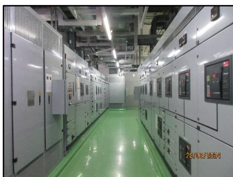
รูปที่ 2-50 ตู้ควบคุมระบบไฟฟ้าหลักของโครงการ (ตู้ MDB)
