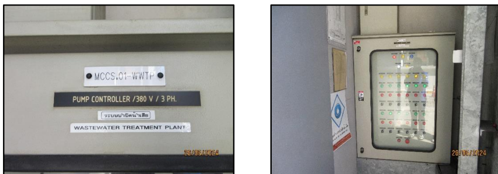
รูปที่ 2-38 มิเตอร์ไฟฟ้าแยกเฉพาะสำหรับระบบบำบัดน้ำเสีย ของโครงการ
