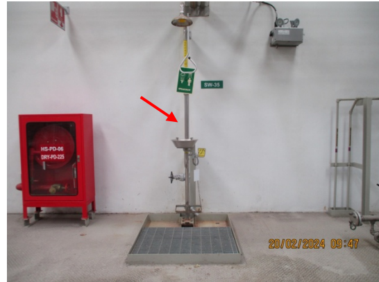
รูปที่ 27 อ่างล้างตาและฝักบัวล้างตัวฉุกเฉิน
