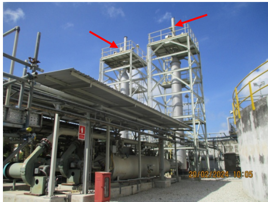
รูปที่ 1 ปล่องระบาย DFTO หน่วยที่ 1 และหน่วยที่ 2
