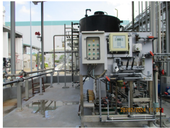
รูปที่ 18 Conductivity Online ที่น้ำระบายทิ้ง จากระบบผลิตน้ำหล่อเย็น
