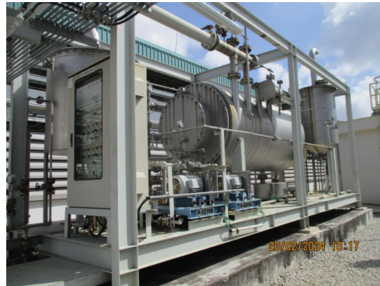
รูปที่ 6 ระบบบำบัดอากาศ บริเวณระบบบำบัดน้ำเสีย
