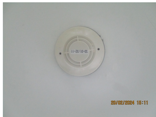
รูปที่ 30 Smoke Detector
