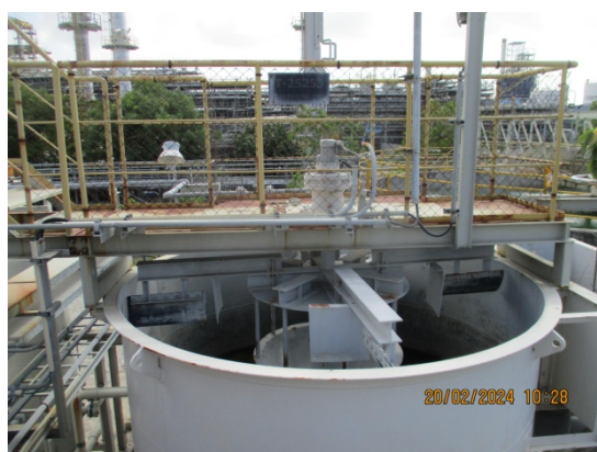
บ่อตกตะกอนแบบ High-rate DAF
