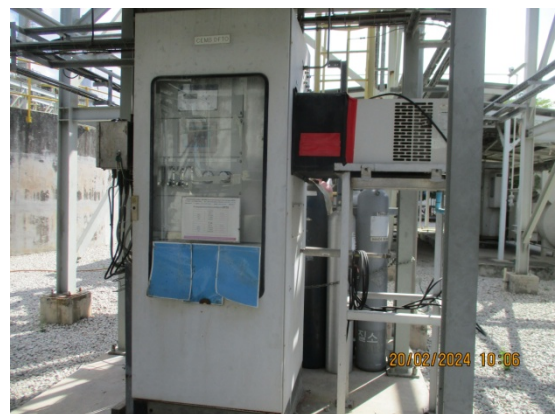
รูปที่ 3 ระบบ CEMs DFTO หน่วยที่ 1 และหน่วยที่ 2
