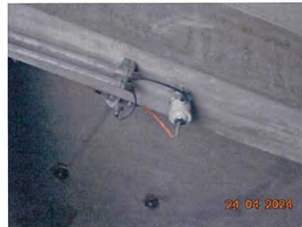
ภาพที่ 2-25 Heat Detector
