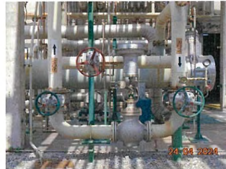
ภาพที่ 2-23 Block Valve ของระบบท่อลำเลียง
