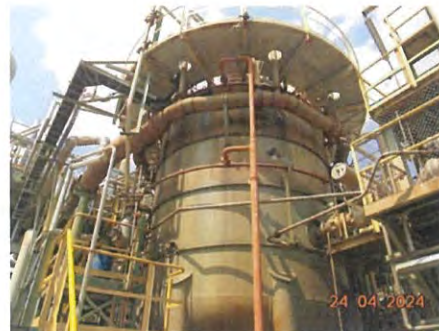
ภาพที่ 2-18 ระบบฉีบน้ำภายนอกถังปฏิกรณ์
