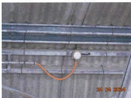
ภาพที่ 2-26 Smoke Detector
