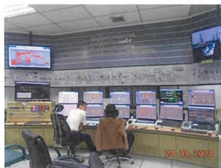
ภาพที่ 2-16 การตรวจสอบและควบคุมกระบวนการผลิตที่ CCR ด้วยระบบ DCS
