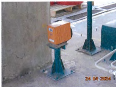
ภาพที่ 2-24 Gas Detector
