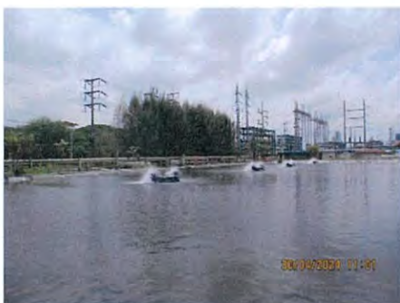
ภาพที่ 2-35 บ่อน้ำดับเพลิงสำรอง (Fire Pond)
