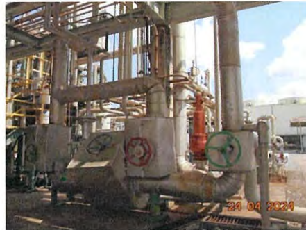
ภาพที่ 2-6 การติดตั้ง Insulation
