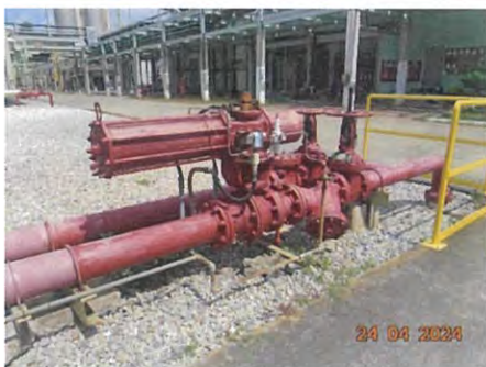
ภาพที่ 2-15 Interlock Valve
