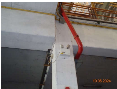
ภาพที่ 6 การติดตั้งสัญญาณเตือนภัย อุปกรณ์ดับเพลิง และไฟฉุกเฉิน
