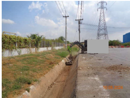
ภาพที่ 12 การขุดลอกตะกอนในรางระบายน้ำ
