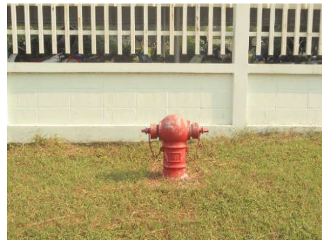
ภาพที่ 14 Fire Hydrant
