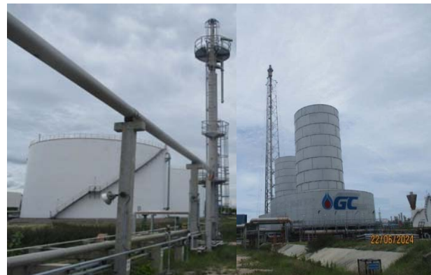
รูปที่ 4 หอเผาความดันต่ำ หอเผาความดันสูง และหอเผานิต EGF
