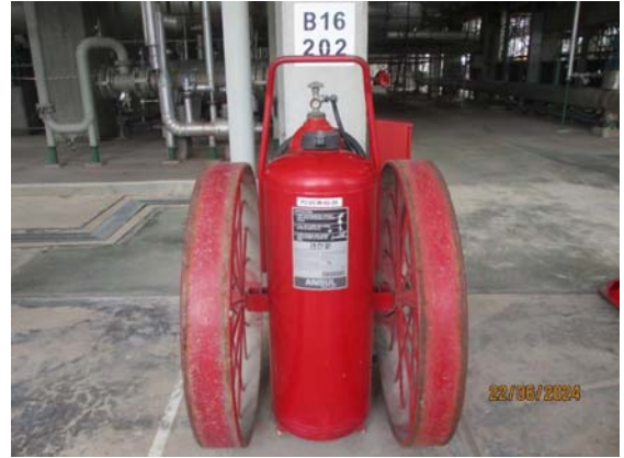
รูปที่ 49 Wheeled Fire Extinguisher
