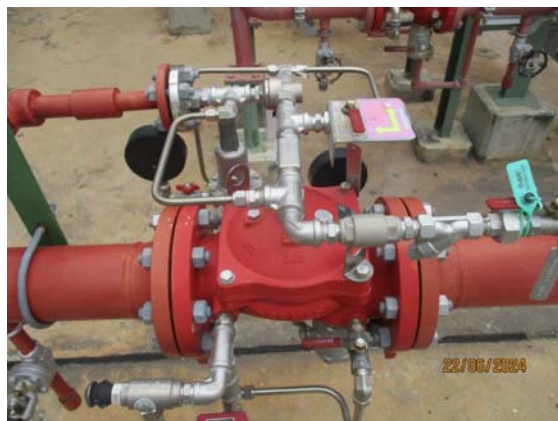
รูปที่ 47 Deluge Valve System
