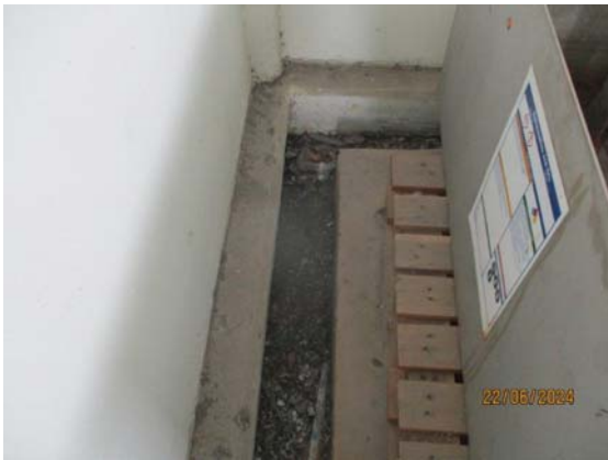
รูปที่ 27 รางระบายรวบรวมน้ำเสีย ภายในอาคารเก็บกากของเสีย
