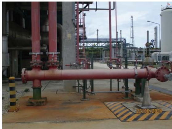
รูปที่ 45 Wet Spray System
