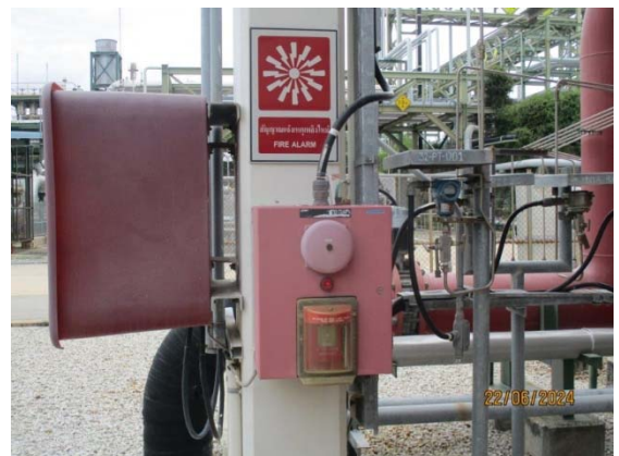
รูปที่ 53 Manual Fire Alarm
