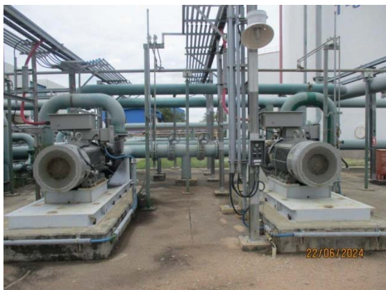
รูปที่ 58 Electric Jockey Pump
