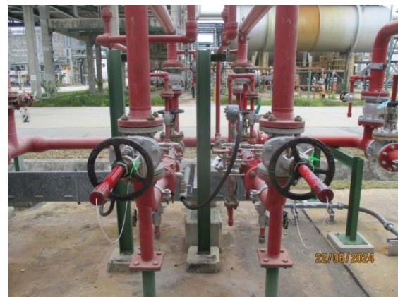
รูปที่ 47 Deluge Valve System
