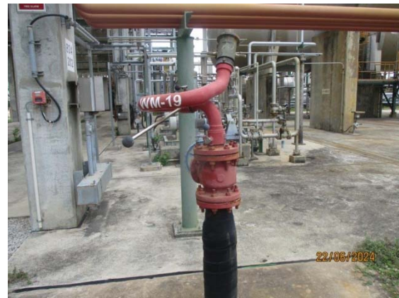
รูปที่ 46 Water Hydrants with Monitors
