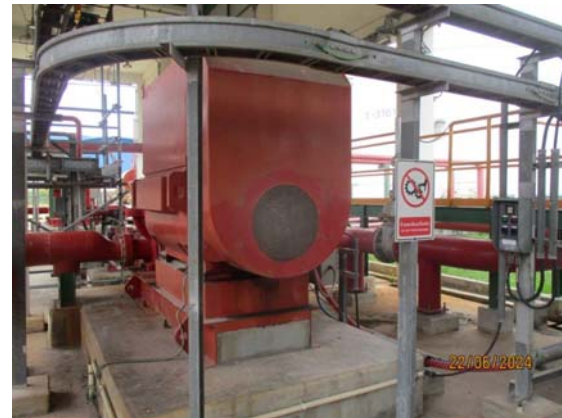
รูปที่ 57 Electric Fire Pump
