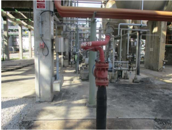
รูปที่ 48 Water Fire Monitor
