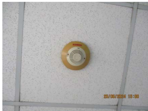
รูปที่ 30 Heat Detector
