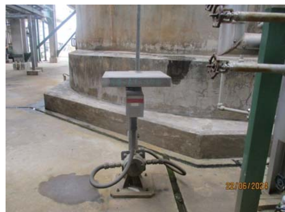
รูปที่ 42 Fixed Gas Detector
