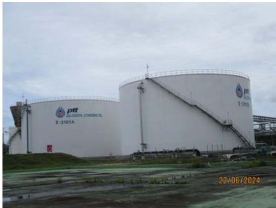
รูปที่ 56 Fire Water Tank (15,000 m 3 )
