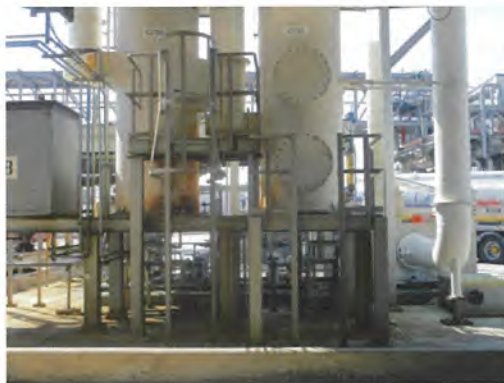
รูปที่ 3-36 Sulfur Scrubber
