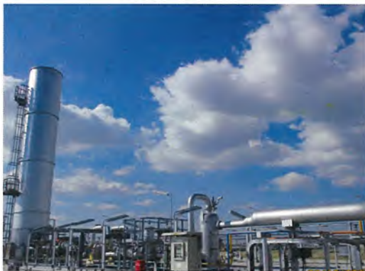
รูปที่ 3-51 ระบบ Vapor Combustion Unit หน่วยที่ 1 (VCU-1)
