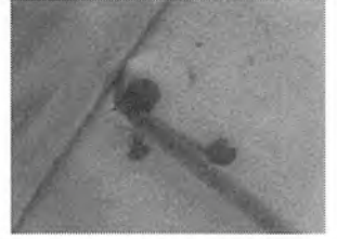
รูปที่ 18 ภาพการติดร่อนเล็กน้อย (เฉพาะที่) ที่ถังข้างถัง
