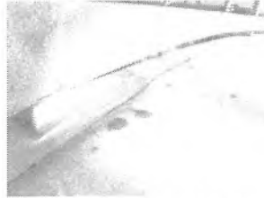
รูปที่ 16 ภาพการติดร่อนเล็กน้อย (เฉพาะที่) ที่ถังข้างถัง
