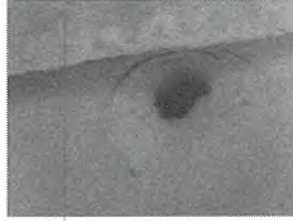
รูปที่ 17 ภาพการติดร่อนเล็กน้อย (เฉพาะที่) ที่ถังข้างถัง
