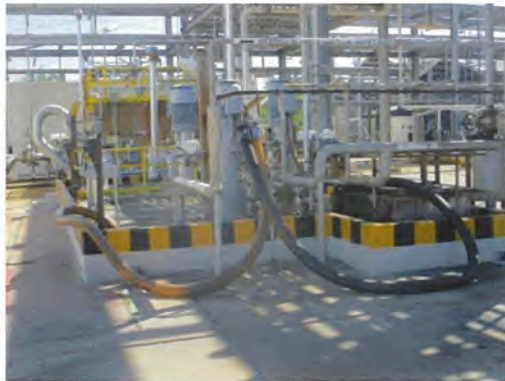
ระบบ Corrugated Plate Interceptor (CPI)
