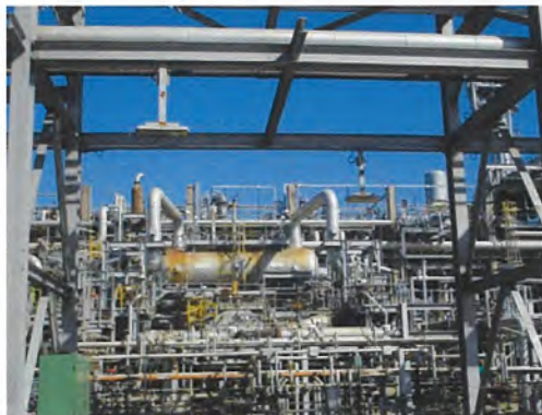
รูปที่ 3-10 Sulfur Recovery Unit (SRU)
