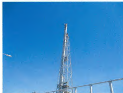
รูปที่ 3-44 ตัวอย่างระบบทอเผา (Flare)
