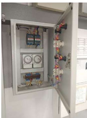
รูปที่ 2.19 ตู้คุมระบบ Timer ตั้งเวลาเปิด-ปิด (วันที่ 12 มิ.ย. 2567)
