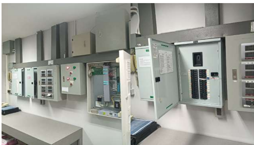
รูปที่ 2.19 ตู้คุมระบบ Timer ตั้งเวลาเปิด-ปิด (วันที่ 12 มิ.ย. 2567)
