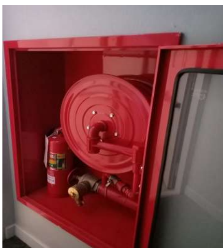
รูปที่ 2.22 ตู้เก็บสายฉีดน้ำดับเพลิงพร้อมอุปกรณ์ (วันที่ 12 มิ.ย. 2567)
