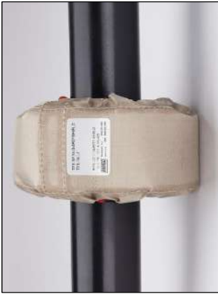
รูปที่ 5-19 ตัวอย่างของการดัดแบบที่ 3 สำหรับวาล์วและจุดเชื่อมต่อที่เป็นหน้าแปลน
