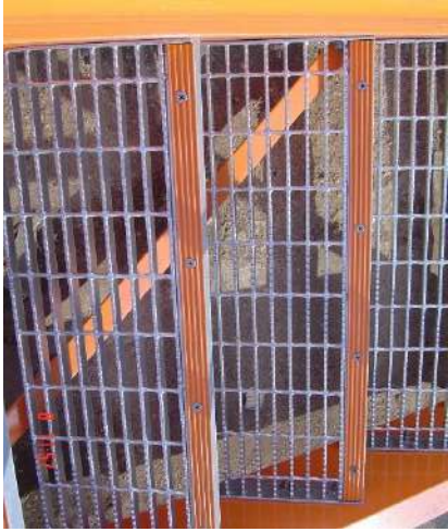
รูปที่ 3-10 ตัวอย่างของจมูกบันไดที่ดี สอดคล้องกับสีของลูกนอนบันได และกอดไปยึดได้เมื่อหมดสภาพ
