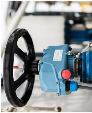
รูปที่ 8-11 อุปกรณ์ระบุตำแหน่งการเปิด-ปิดของ Manual valve (Manual Valve Position Indicator)
