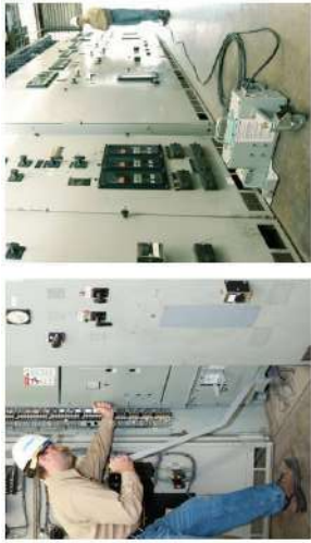
รูปที่ 6-4 รูปภาพช่วยมีแสดงวิธีการ Racking breaker แบบทั่วไปซึ่งพนักงานต้องยืนอยู่หน้าตู้ Switchgear ซึ่งประตูเปิดอยู่ ซึ่งมีความเสี่ยงที่จะได้รับอันตรายจากการอาร์ก (Arc flash) ขณะที่อยู่ภาพขวามือคือการ remote-racking
