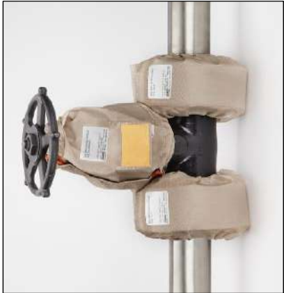
รูปที่ 5-19 ตัวอย่างของการดัดแบบที่ 3 สำหรับวาล์วและจุดเชื่อมต่อที่เป็นหน้าแปลน
