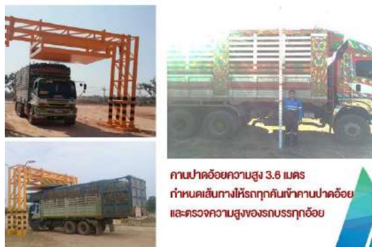
รูปที่ 2-46 รูปประตูคานดำนบน โดยมีความสูงจากพื้นดิน 3.6 เมตรไม่น้อยกว่า 2 ประตู
