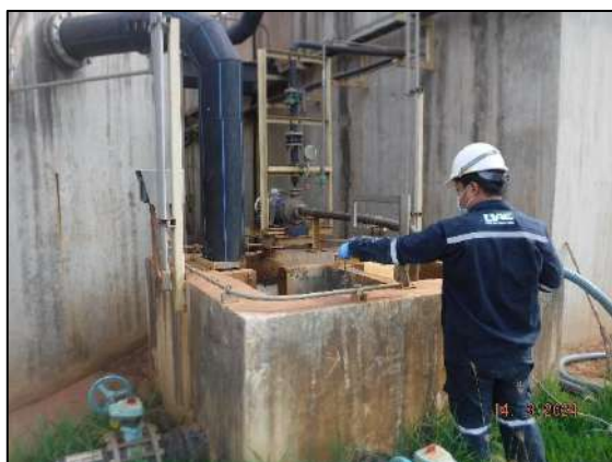
บ่อตรวจสอบคุณภาพน้ำทิ้ง ระบบบำบัดน้ำเสีย
