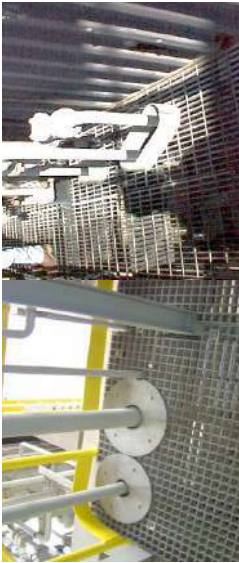
รูปที่ 2-14 ลักษณะการติดตั้ง Donut Plate สำหรับเปิดช่องว่าง และการติดตั้งขอบกันของตก (Toeboards/Kick plate)
