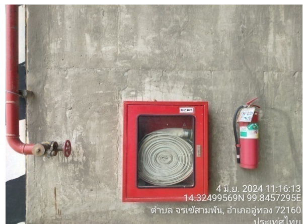
หัวรับน้ำดับเพลิงและสายฉีดน้ำดับเพลิง
