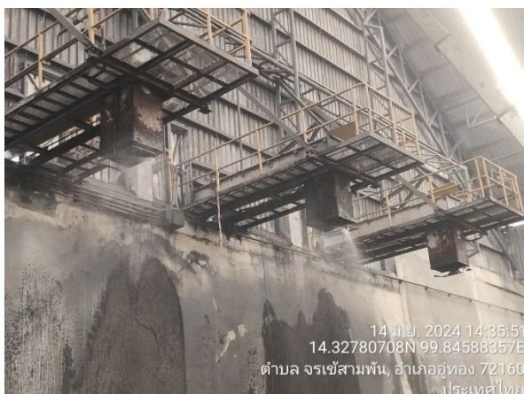
รูปที่ 2-15 ระบบฉีดพรมเถ้านภายในอาคารเก็บเถ้า
