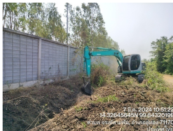
รูปที่ 2-24 การขุดลอกรางระบายน้ำรอบพื้นที่โครงการ
