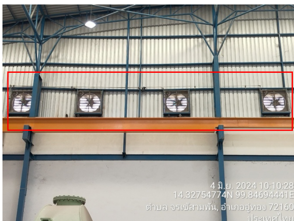
รูปที่ 2-48 ระบบระบายอากาศจากพื้นที่ปฏิบัติงาน
