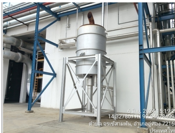
รูปที่ 2-9 อุปกรณ์ป้องกันเสียงดัง (Silencer)
