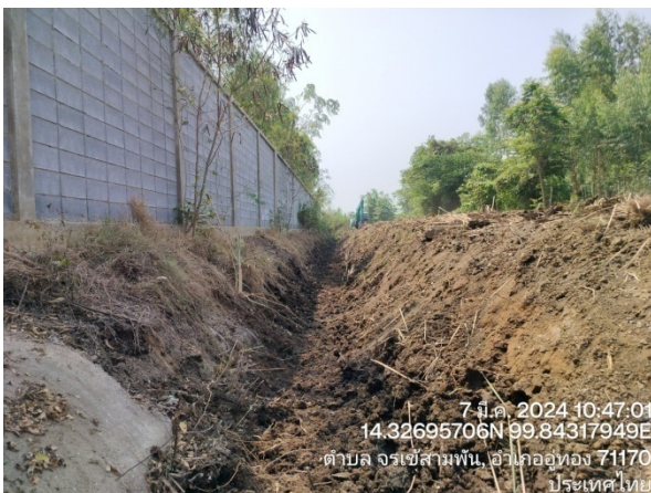
รูปที่ 2-19 รางระบายน้ำ และรวบรวมน้ำฝน ในพื้นที่โครงการ
