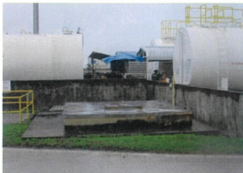
รูปที่ 2-12 บ่อดักน้ำมันบริเวณท่าเทียบเรือ
