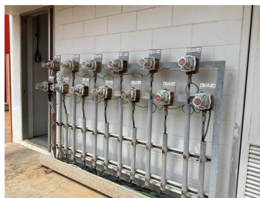
รูปที่ 3-30 Emergency Shut Off Valve ที่ Loading Arm
