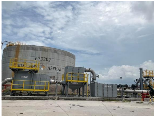
รูปที่ 3-6 ระบบควบคุมไอระเหยจากท่อระบายของถังเก็บกักยางมะตอย
