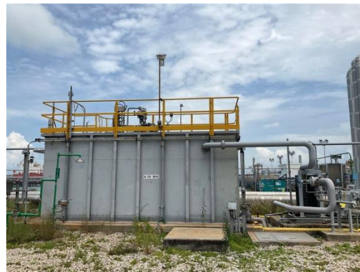
รูปที่ 3-9 ระบบบำบัดน้ำเสียภายในท่าเทียบเรือ (Sanitary Treatment System)
