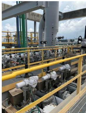
รูปที่ 3-2 ระบบหยุดปฏิบัติการฉุกเฉิน (Shore Line Block Valve)
