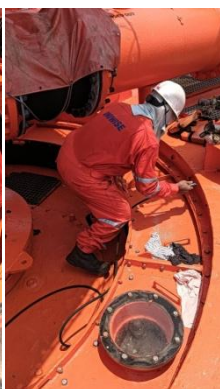
รูปที่ 3-38 การซ่อมบำรุงและการเปลี่ยนเส้นท่อ
