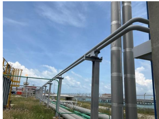
รูปที่ 3-3 ท่อรวบรวมไอลิผลิตภัณฑ์และวัตถุดิบ ที่เกิดจากกิจกรรมการขนถ่ายไปยังหอเผา (Flare)
