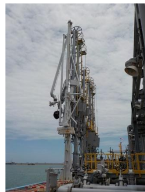
รูปที่ 3-5 แขนขนถ่ายวัตถุดิบและผลิตภัณฑ์ (Loading Arm)
