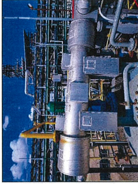
ระบบ Vapor condenser บริเวณถังเก็บเฮกเซนและถังเก็บตัวกระตุ้นตัวเร่งปฏิกิริยา
