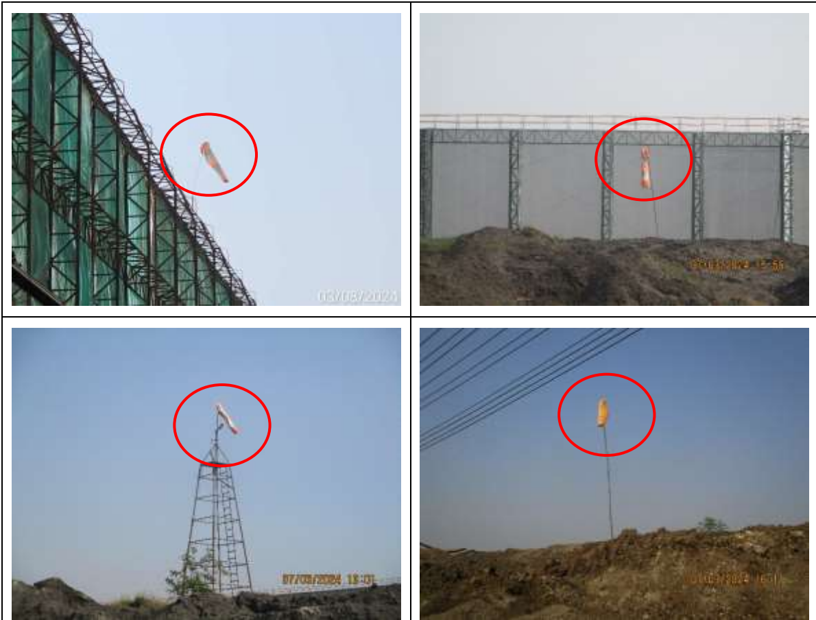
รูปที่ 11 การติดตั้งอุปกรณ์บอกระดับมลพิษทางลม
