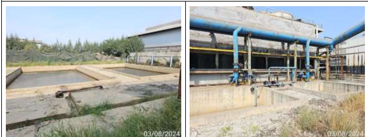
รูปที่ 14 บ่อพักน้ำทิ้งคอนกรีตรองรับน้ำทิ้ง จากระบบหล่อเย็น
