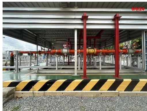
ภาพที่ 2.2-5 วาล์วควบคุม และระบบวาล์วใต้ดิน
