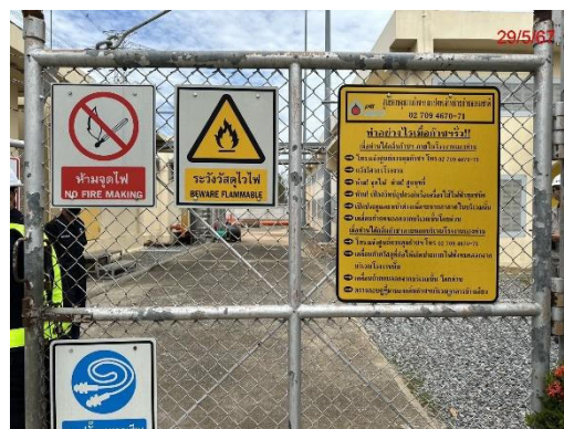
ภาพที่ 2.2-4 ข้อความและหมายเลขโทรศัพท์แจ้งเหตุฉุกเฉิน และป้ายเตือนตามแนวรั้วกัน
