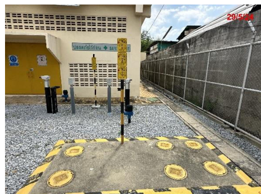
ภาพที่ 2.2-10 ระบบบازلวใต้ดิน
