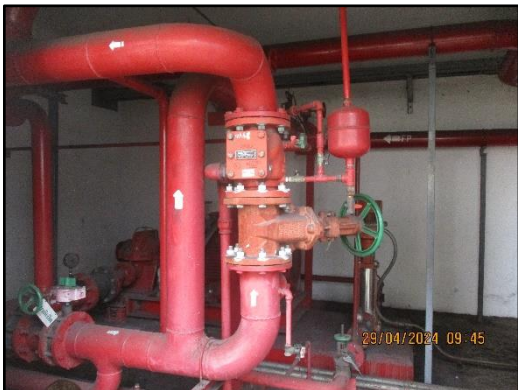
ภาพที่ 2.44 เครื่องสูบน้ำและอุปกรณ์ดับเพลิงภายในโครงการ
