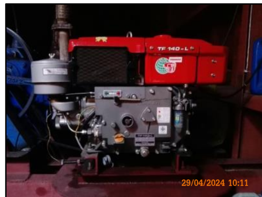
ภาพที่ 2.50 เครื่องปั่นไฟพร้อมสายไฟและปลั๊กไฟภายในเรือลำเลียงสินค้า
