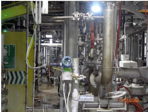
รูปที่ 64 ระบบวัดอุณหภูมิและความดันภายในถังปฏิกริยาฟอสฟอไรต์ POP (POP Reactor)
