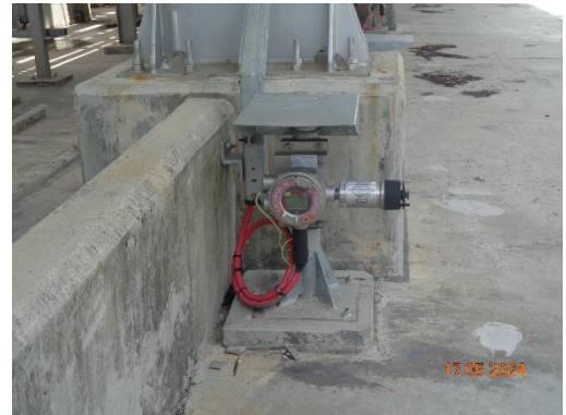
รูปที่ 50 Toxic Gas Detector บริเวณอุปกรณ์การผลิตที่เกี่ยวข้องกับเอทิลีนออกไซด์
