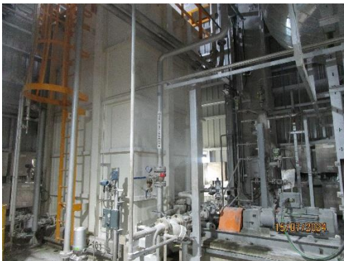
รูปที่ 35 ถังเก็บ Waste Hydrocarbon
