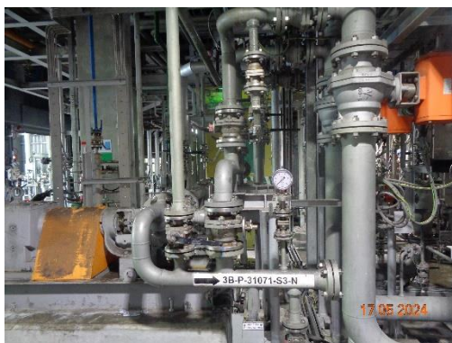
รูปที่ 61 ระบบ Isolate Valve บริเวณอุปกรณ์สูบน้ำ
