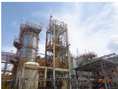
รูปที่ 6 ระบบบำบัดสารอินทรีย์ระเหยแบบเปียก (VOCs Wet Scrubber)
