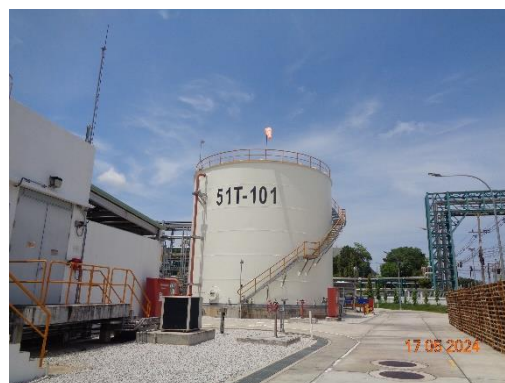
รูปที่ 54 ถังเก็บน้ำใส (Clarified Water Tank)
