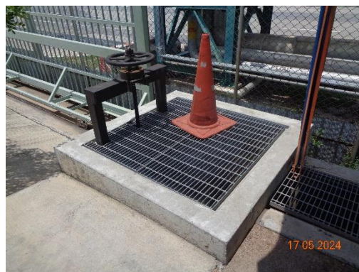
รูปที่ 28 บ่อตรวจสอบคุณภาพน้ำ (Inspection Pit) บริเวณรางระบายน้ำ
