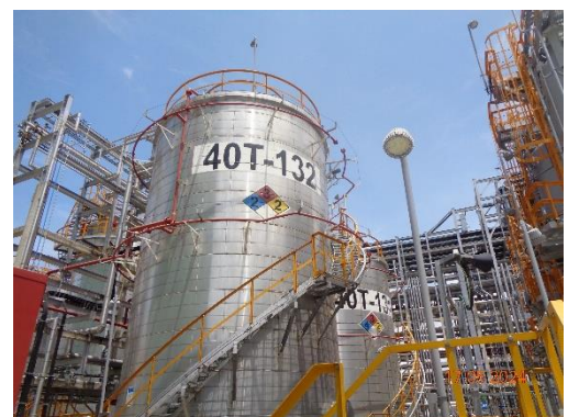
รูปที่ 3 ถังเก็บสไตรีน
