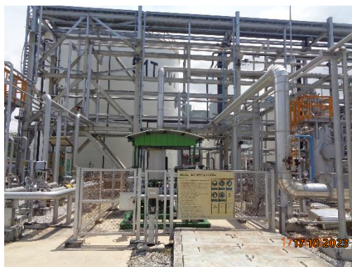
รูปที่ 46 ระบบก๊าซไนโตรเจน (Nitrogen Blanketing)
