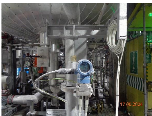
รูปที่ 63 ระบบวัดอุณหภูมิและความดันภายในถังปฏิกิริยาโพลีโอลชนิด PPG (PPG Reactor)
